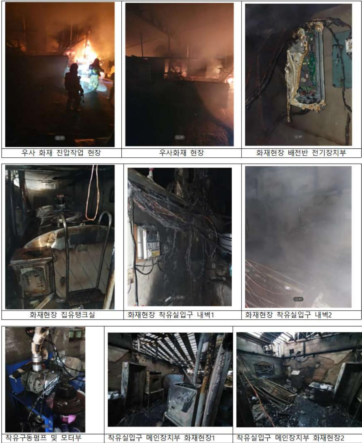
그림 11 실증대상농가 화재발생 및 ICT 장치 소실현장
