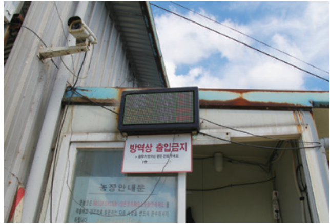
돈사 내부 환경을 실시간 감독하기 위해 돈사 외부에 암모니아 가스 수치 등이 표시된 전광판을 설치했다.
