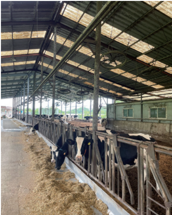
유현오씨는 구축사도 천장을 높이는 등 리모델링한다는 구상이다. 천장을 높인 덕분에 대형 팬을 설치할 수 있었다. 젖소가 열을 덜 받고 환기도 잘된다.
