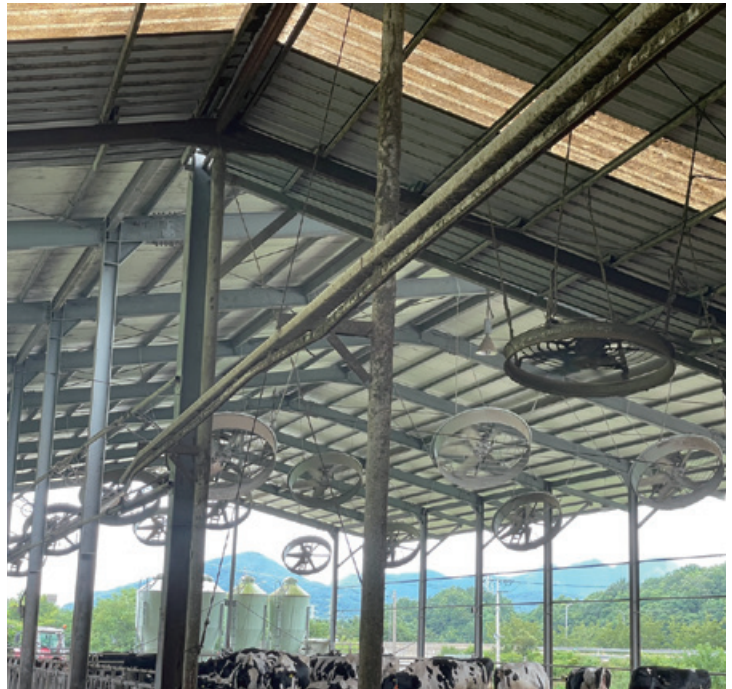
유현오씨는 구축사도 천장을 높이는 등 리모델링한다는 구상이다. 천장을 높인 덕분에 대형 팬을 설치할 수 있었다. 젖소가 열을 덜 받고 환기도 잘된다.
