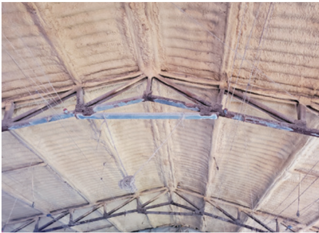
축사 천장에 우레탄을 보강한 모습. 이를 통해 여름철 내부 온도를 낮출 수 있다.
