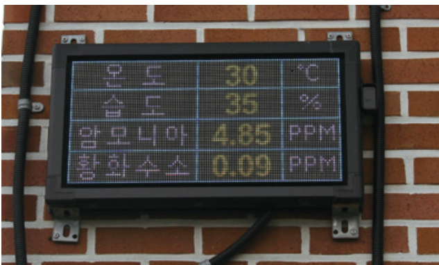
돈사 외벽에 설치된 악취저감시설 전광판에 돈사 외부의 온도, 습도, 암모니아, 황화수소 수치가 표시돼 있다.
