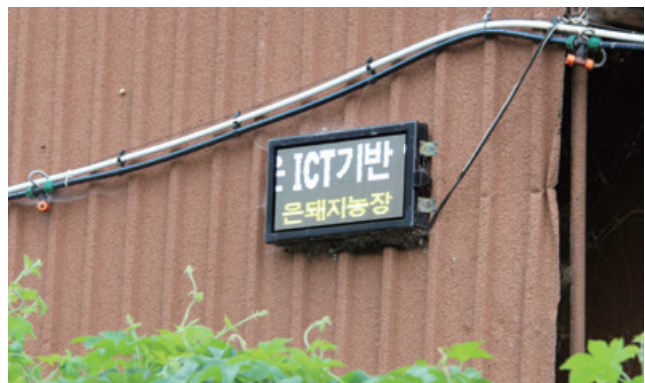
돈사 외벽에 설치된 악취저감시설 전광판에 돈사 외부의 온도, 습도, 암모니아, 황화수소 수치가 표시돼 있다.
