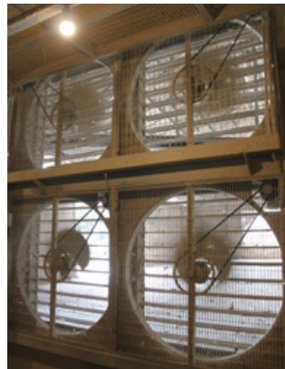
안성농장의 계사에 설치된 21개의 환풍기는 냉각패드와 함께 내부 공기를 환기시키는 역할을 한다.
