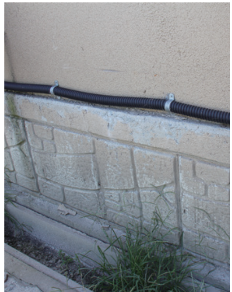
콘크리트를 만든 돈사 외벽
