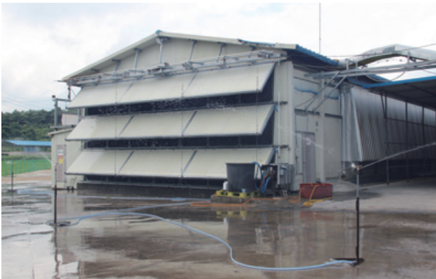
계사 외부 전경. 여름철에는 계사 외부 바닥에도 스프링클러로 지하수를 뿌려 온도를 낮춘다.
