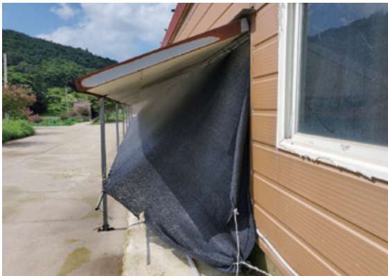
축사 외부에 설치된 스프링클러.
