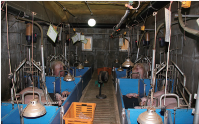
돈사에 설치된 자동화시설.
