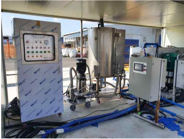
그림 40. 세척수 리사이클링 장치와 오존발생기
