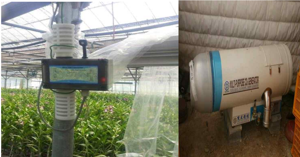
<그림 3-27> 양평 호접란 농가에 있는 CO2 제어 장치 및 CO2 발생기
