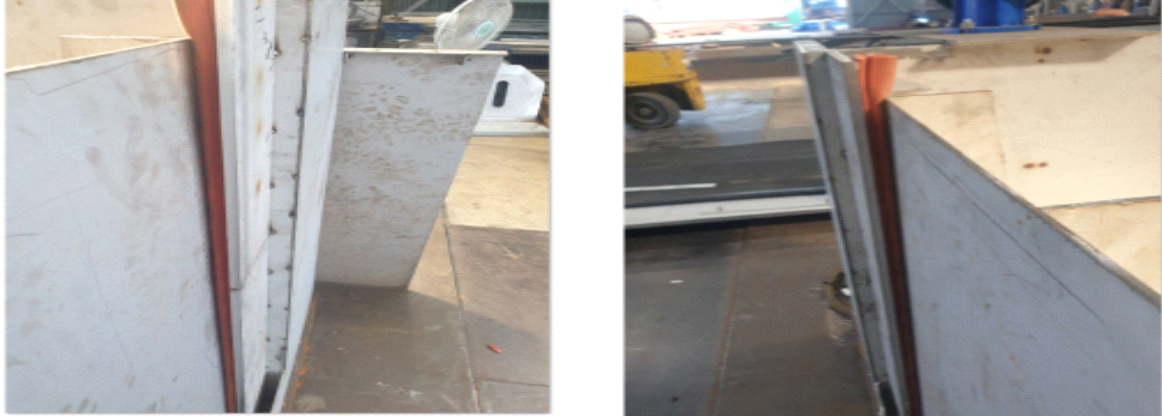
<그림 4-29> 지수교무 부착 및 가공(좌, 우)
