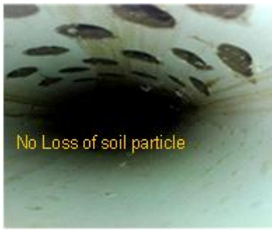
(a) Inside conduit
