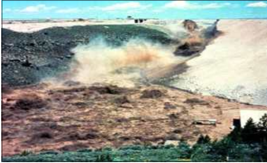
[그림 1.15] 댐 상부 붕괴 및 월류(USBR)
