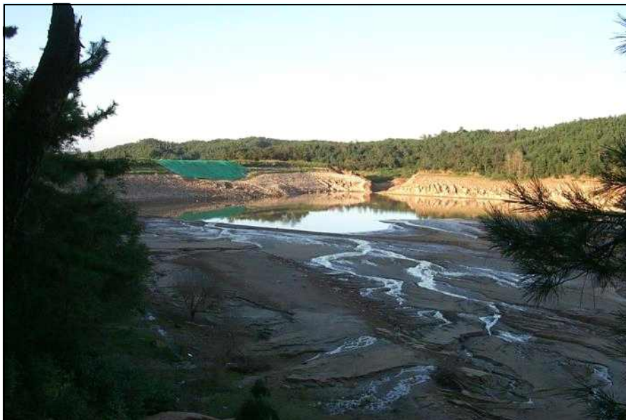
[그림 1.5] 동막저수지 붕괴 현장
