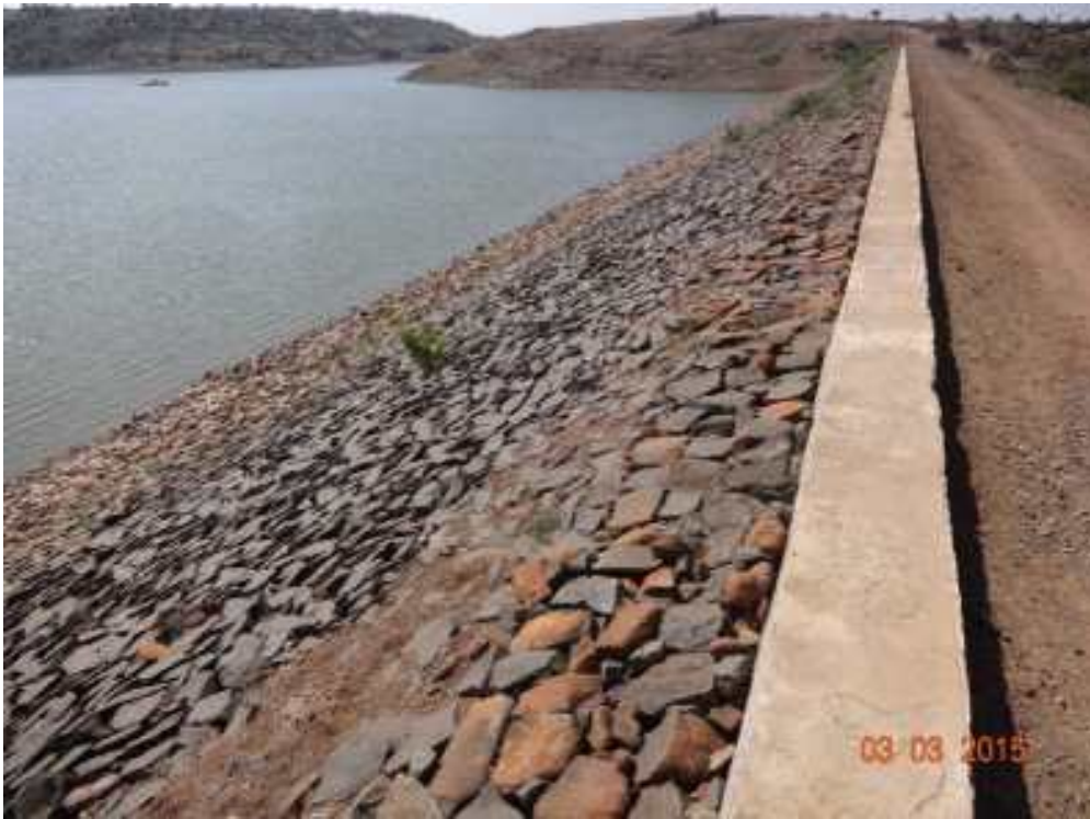
[그림 1.43] Parapet wall 설치 전경
