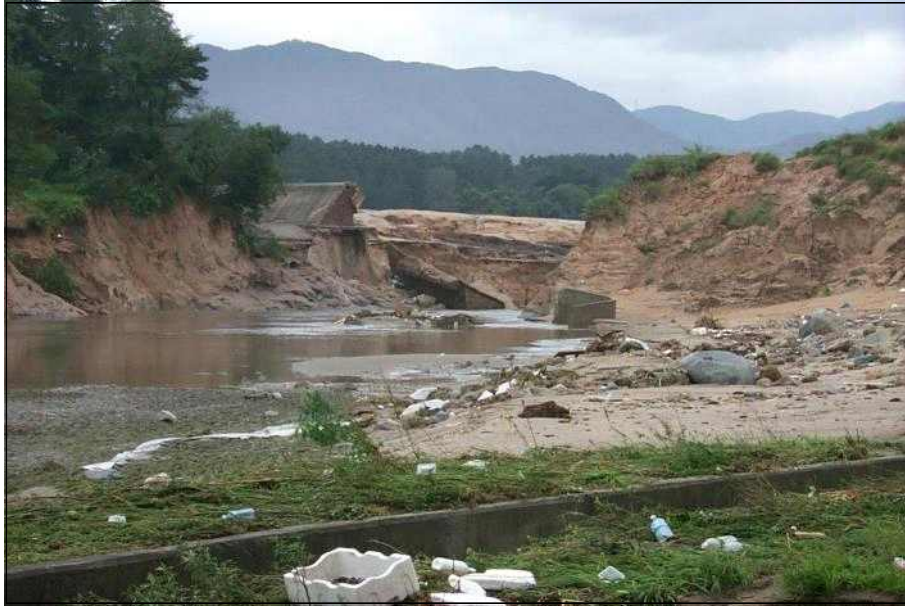
[그림 1.3] 장현저수지 여수로 붕괴 현장
