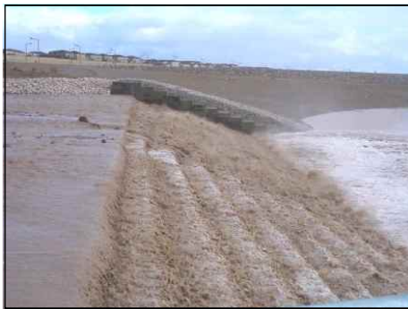
[그림 1.45] Red Rock 지역의 댐에 설치된 RCC 보조여수로 출처 : Small Dams Design, Surveillance and Rehabilitation(CIGB ICOLD)
