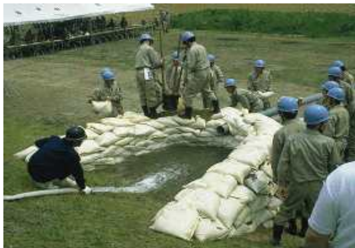
[그림 1.58] 월륜공법의 현장시공 전경
