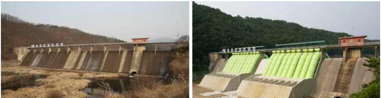
[그림 3.128] 미호 저수지 사이편 여수로 추가시공 사례
