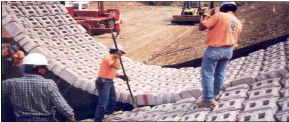
[그림 1.47] 댐 사면에 대한 조립된 콘크리트 블록의 거치
