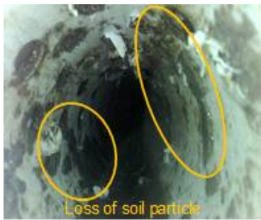
(a) Inside conduit
