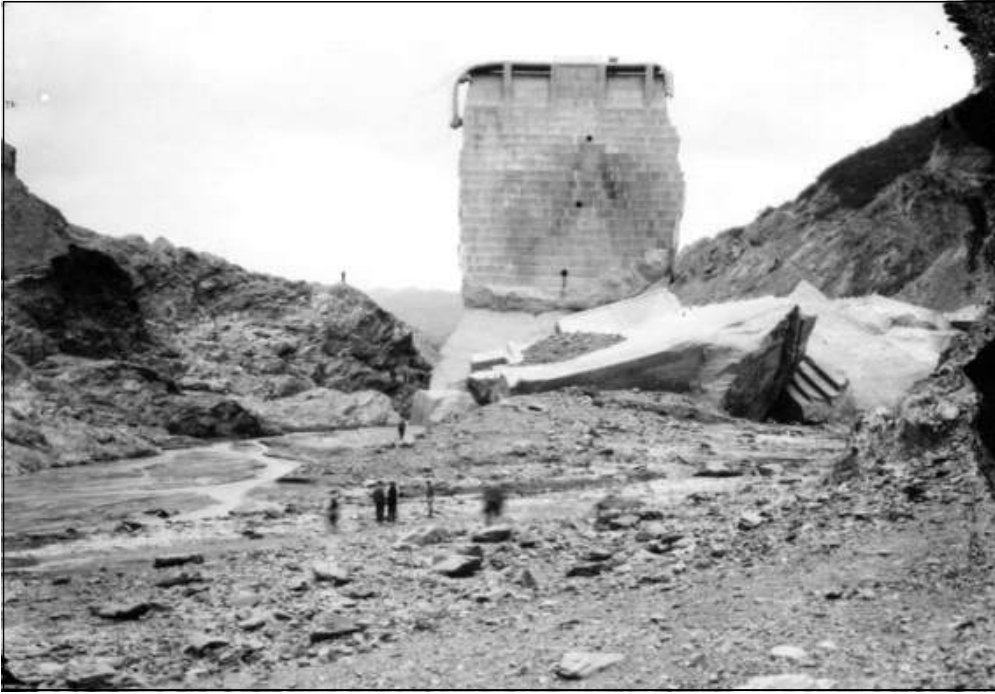
[그림 1.21] 붕괴 후 성프란시스 댐 전면(USGS)
