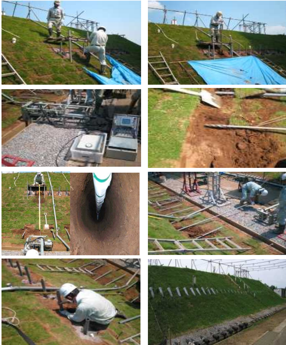
[그림 1.53] L형 드레인공법 단계별 시공전경
