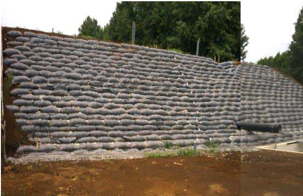
[그림 1.51] 제체에 적용한 흙부대 공법
