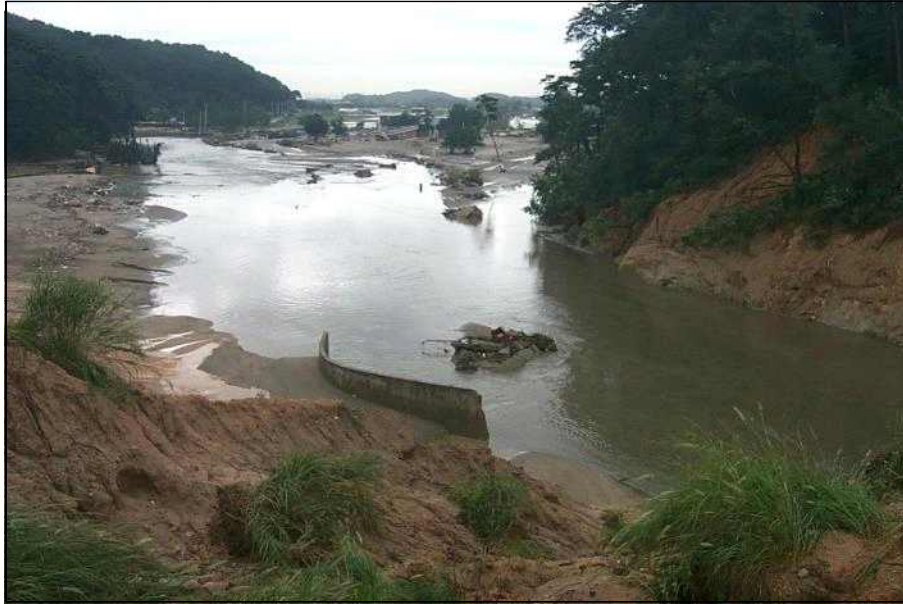
[그림 1.4] 장현저수지 붕괴 및 하류부 피해 현장
