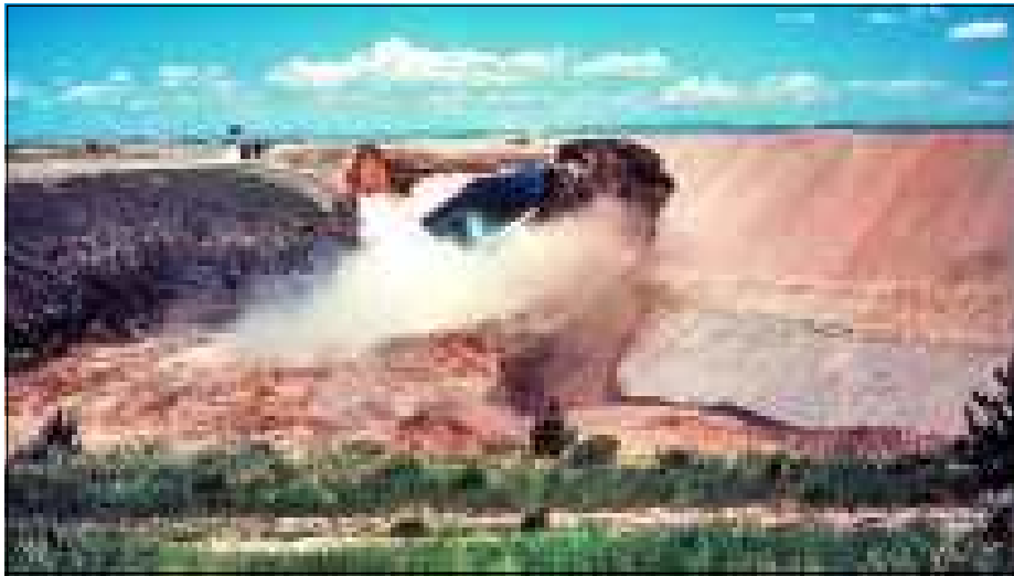
[그림 1.16] 댐 상단 파이핑 진행 붕괴(USBR)
