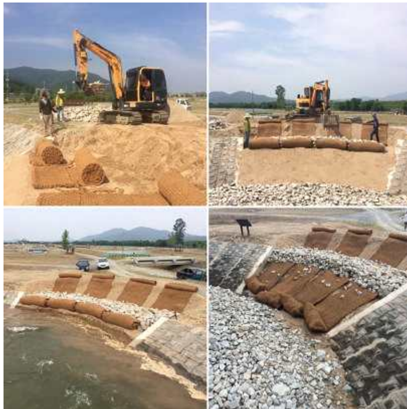
[그림 1.39] Eco-hybrid 롤링매트 실규모 하천수로 검증 실험(한국건설기술연구원, 2016)
