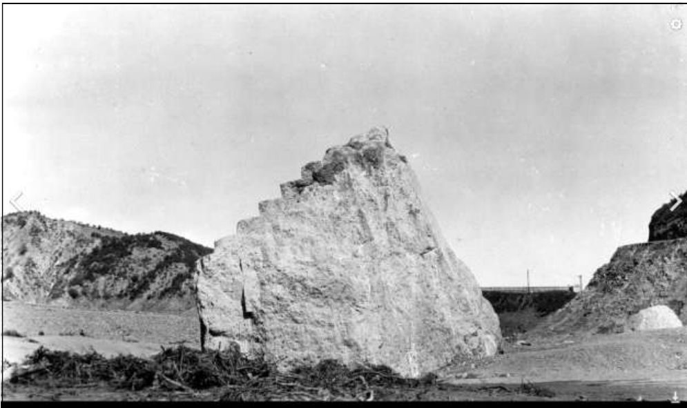
[그림 1.20] 붕괴 후 성프란시스 댐 측면(USGS)
