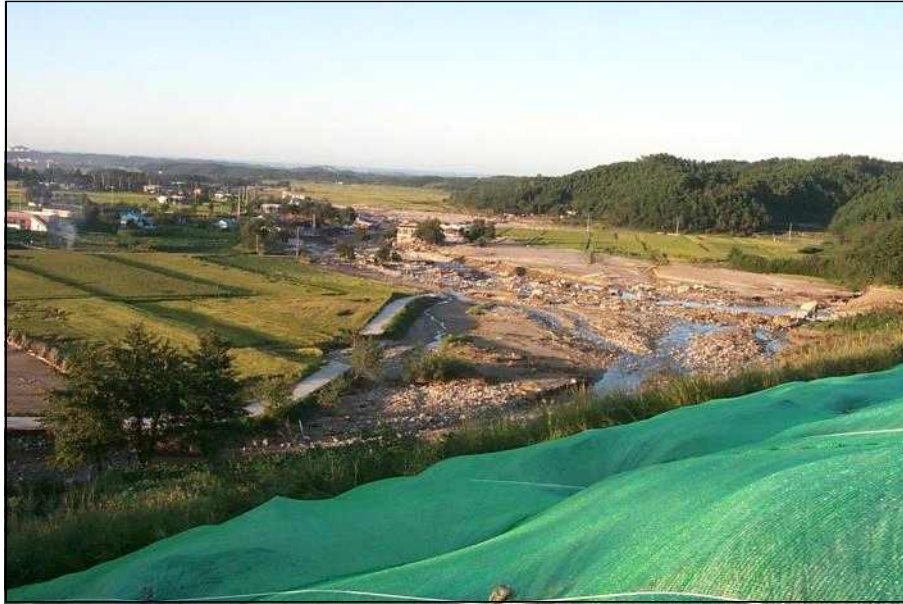
[그림 1.6] 동막저수지 붕괴 및 하류부 피해 현장
