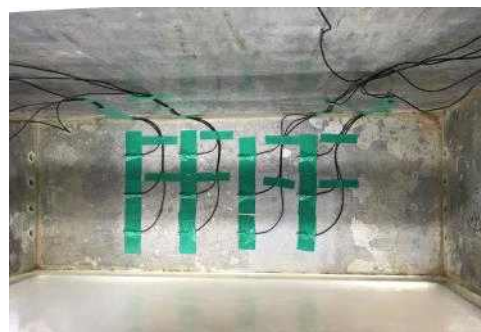
(b) 간극수압계 설치
