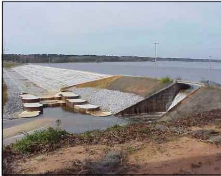
[그림 1.44] Tholocco Dam에 설치된 RCC 보조여수로 출처 : Small Dams Design, Surveillance and Rehabilitation(CIGB ICOLD)
