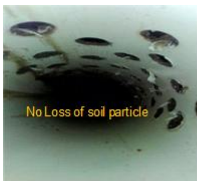
(a) Inside conduit
