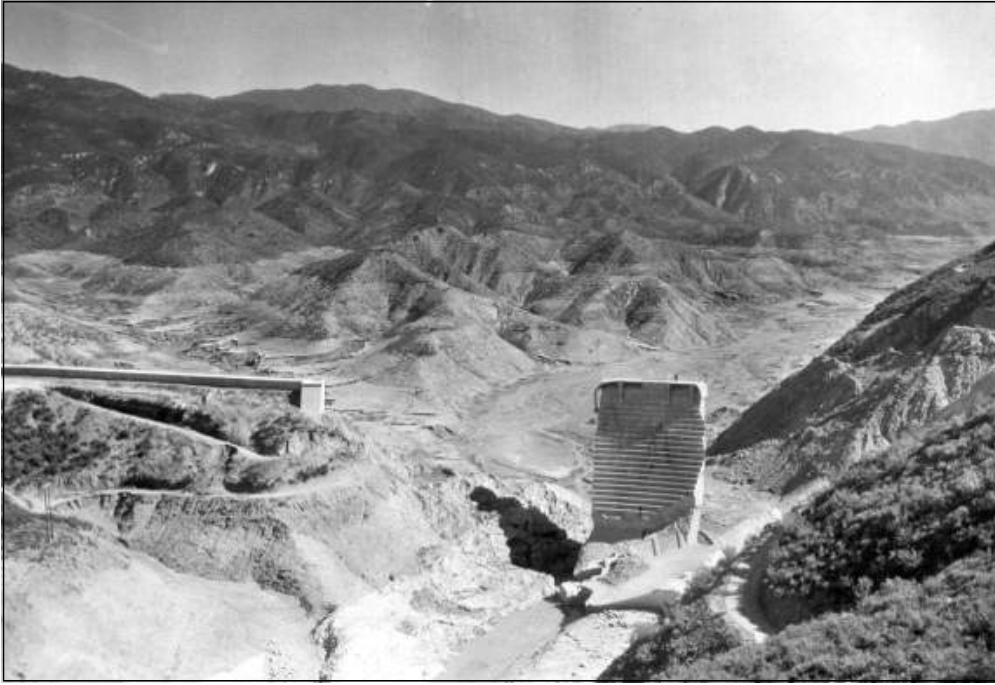
[그림 1.19] 붕괴 후 성프란시스 댐(USGS)
