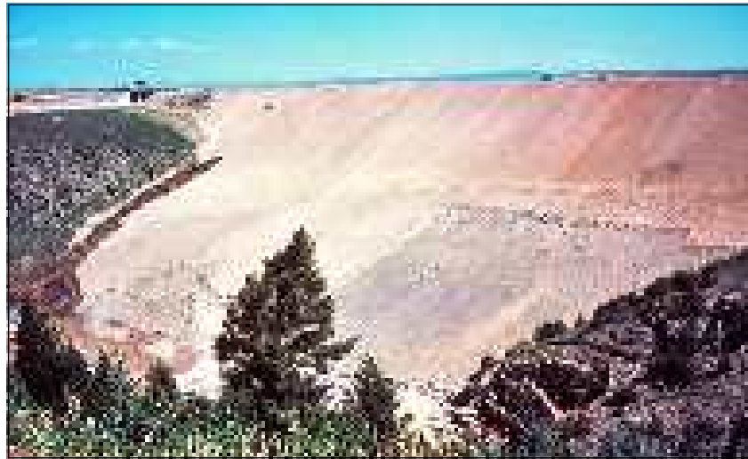
[그림 1.12] 댐 사면중간에 파이핑 발생(USBR)
