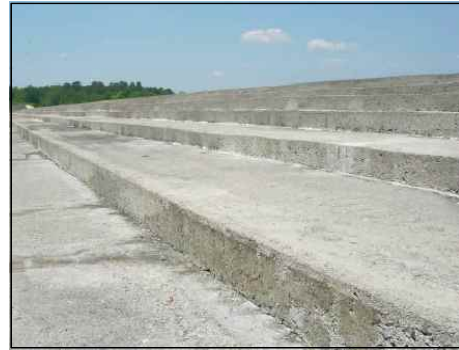
[그림 1.44] Tholocco Dam에 설치된 RCC 보조여수로 출처 : Small Dams Design, Surveillance and Rehabilitation(CIGB ICOLD)
