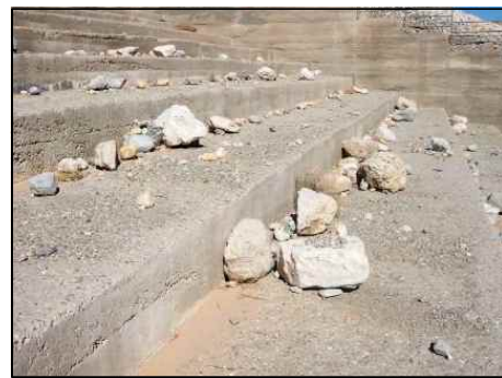
[그림 1.45] Red Rock 지역의 댐에 설치된 RCC 보조여수로 출처 : Small Dams Design, Surveillance and Rehabilitation(CIGB ICOLD)
