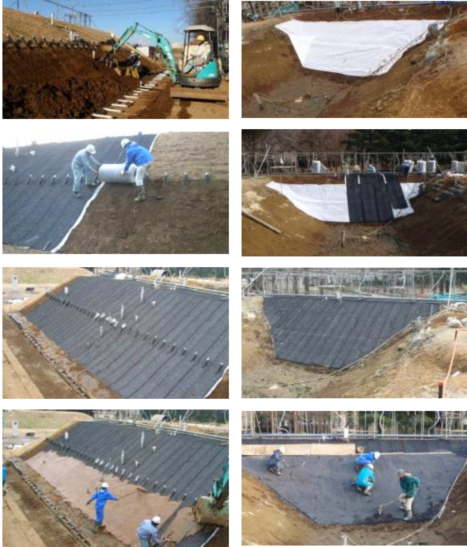
[그림 1.52] 제체표면 피복공법 단계별 시공전경
