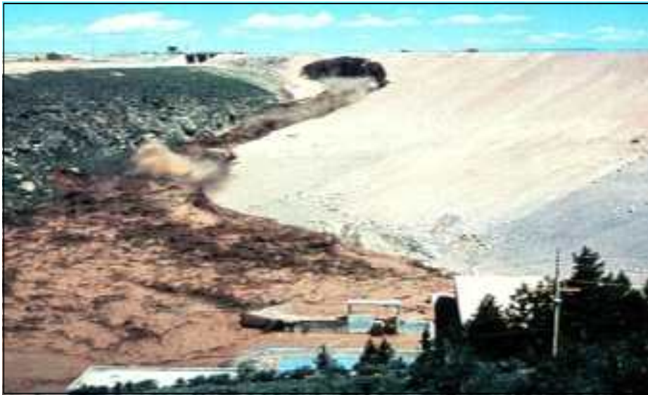
[그림 1.14] 댐 공동 확대 및 상부로 진행(USB)
