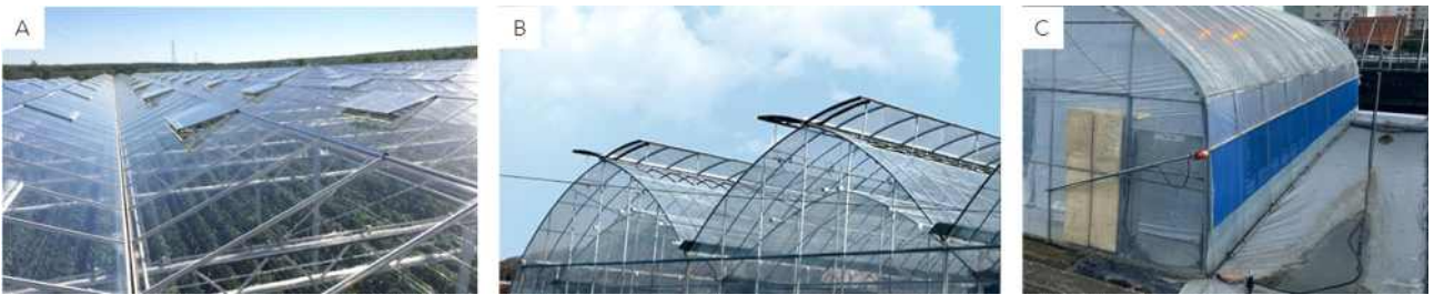
[그림 6-2] 스마트온실의 일중천창. (자료출처 : A, prinsgreenhouse; B, 우성하이텍)
