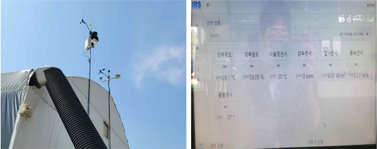
[그림 2.76] 스마트온실 외부기상대(온·습도, 이슬점, 강우, 일사, 풍향 및 풍속 센서)
