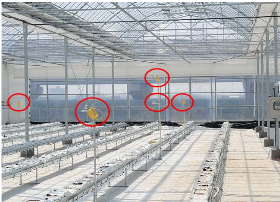
그림 2-2-5. 플라스틱 연동 온실의 일사량 센서 배치 모습
