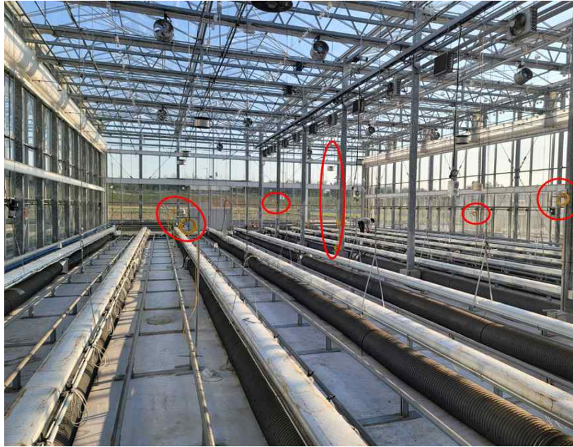
그림 2-2-8. 유리 연동 온실의 일사량 센서 배치 모습
