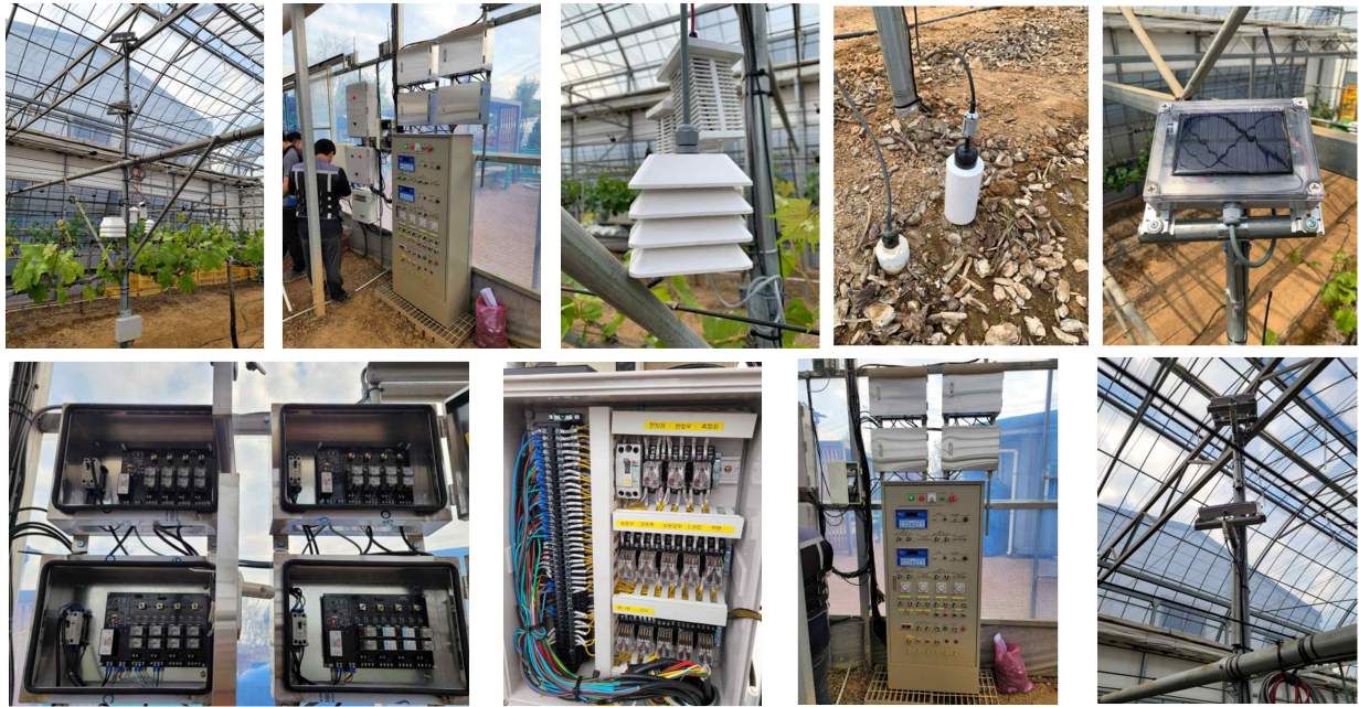
<실증 시험 장치 설치 모습>
