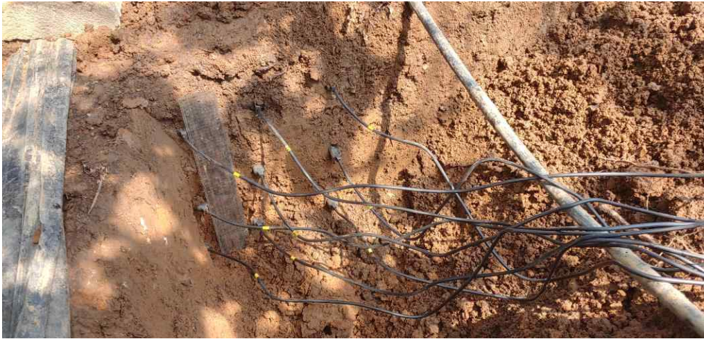
<깊이, 거리별 토양수분함량 측정 센서 설치>
