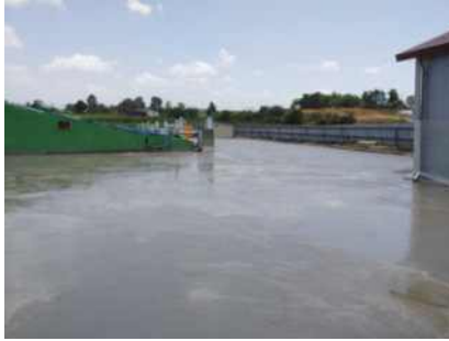
<부지 정리> (기존) 자갈바닥 → (변경) 콘크리트바닥
