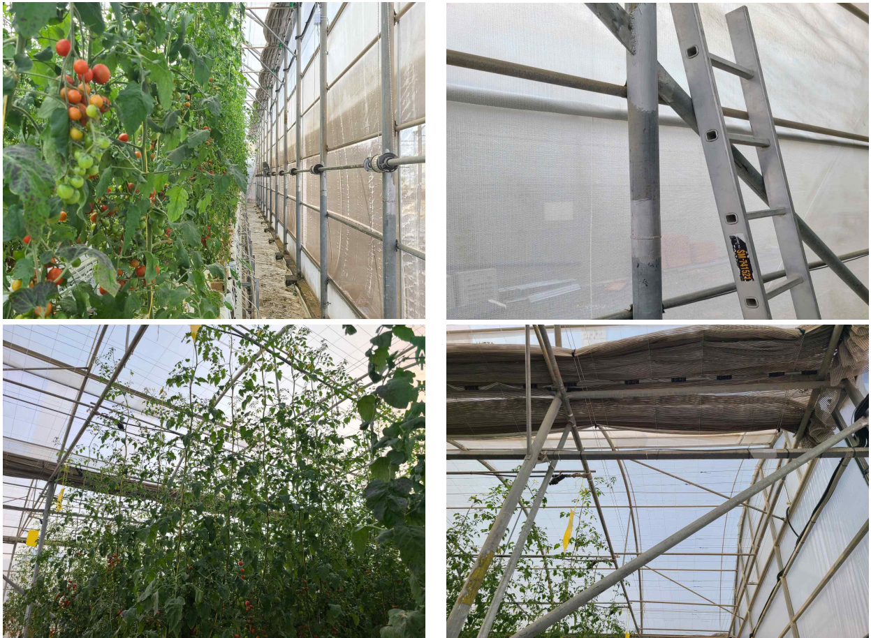
그림 55. UAE 리모델링 온실의 골조 시공
