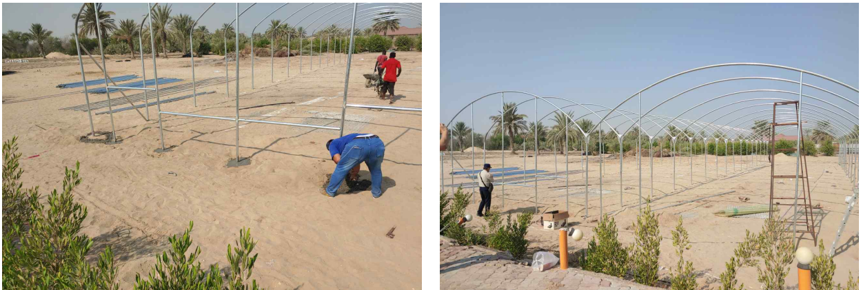
그림 74. UAE 현지 관행온실의 시공 사진(현지업체 시공 사진)
