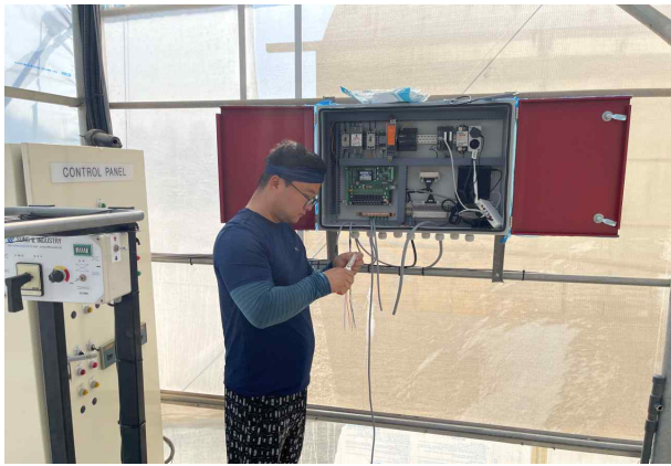
복합환경제어 시스템 설치 공사
