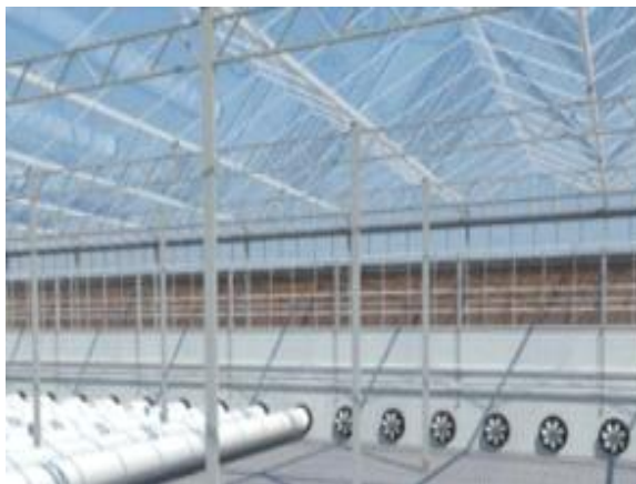
네덜란드형 반밀폐 온실 설치에
