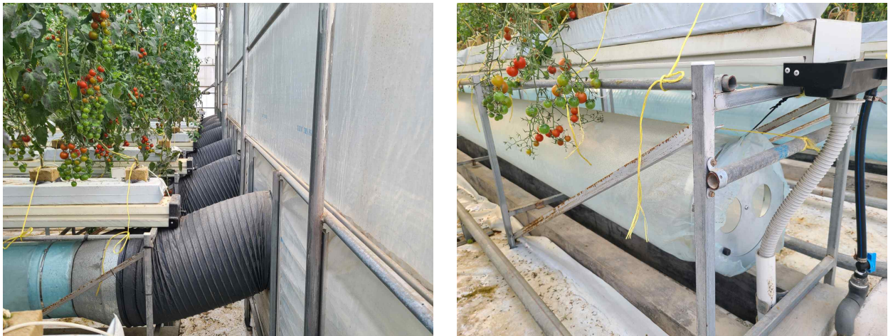
그림 58. UAE 리모델링 온실에서 사용된 FCU 및 덕트
