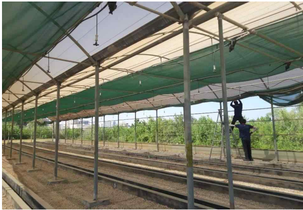
외부피복 및 차광스크린 철거
