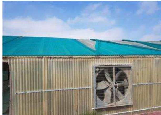
<압달리 온실 외부(팬 부) 전경>
