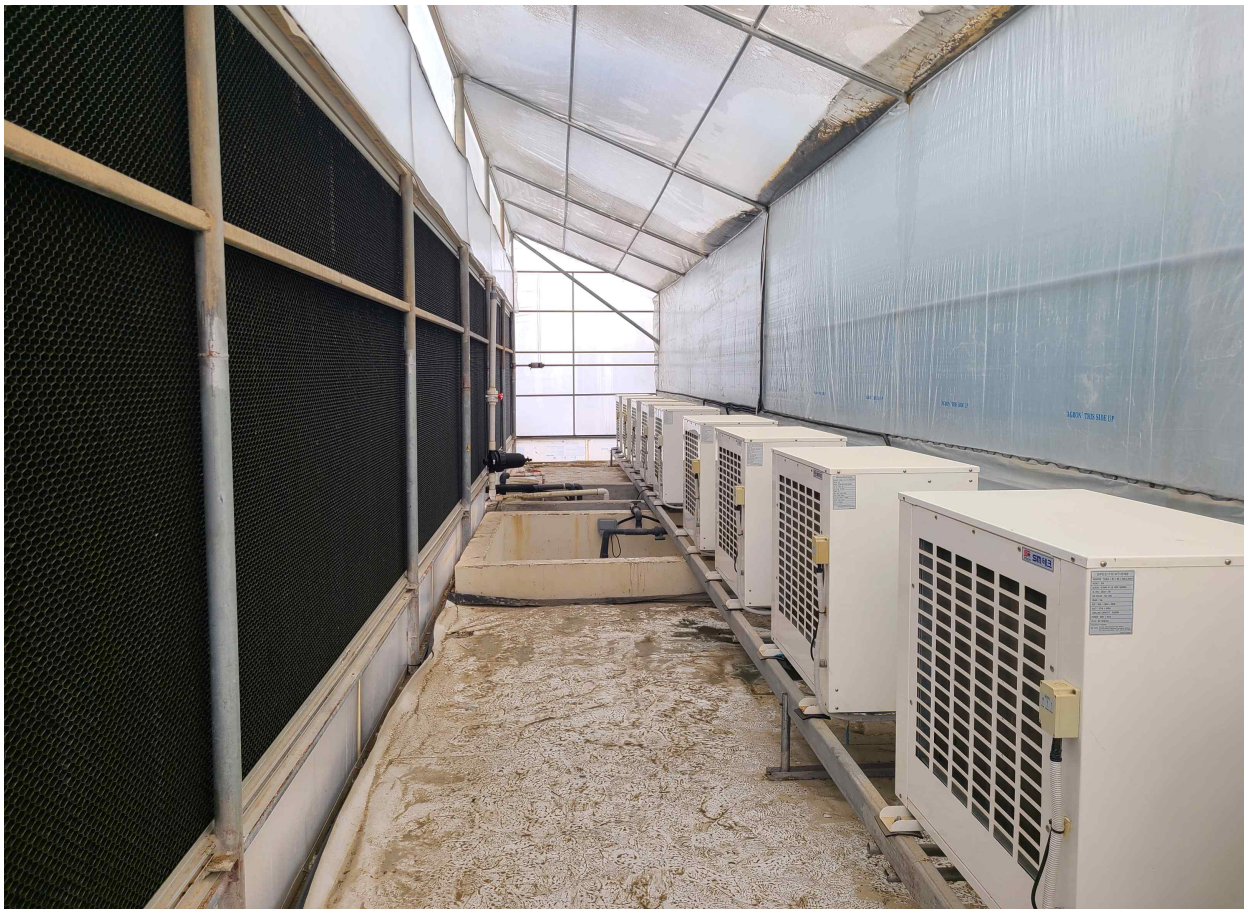
그림 59. UAE 리모델링 온실에서 사용된 FCU 및 덕트
