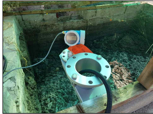
센서 거치대 및 수위계 설치
