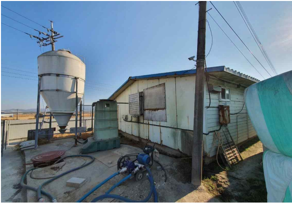
원분뇨 저장조 (콘크리트 매립)
