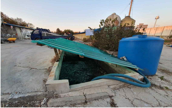
원분뇨 저장조 (콘크리트 매립)
