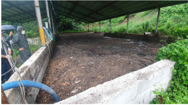
지상형 콘크리트 저장조
