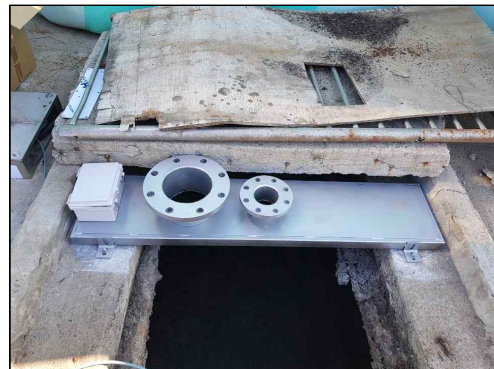
센서 거치대 설치
