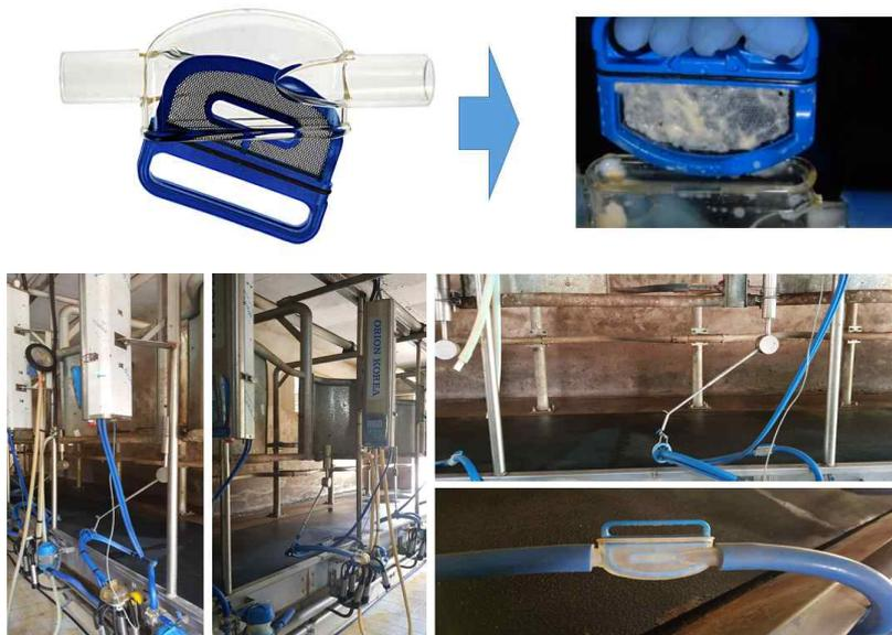
주) In-line filter는 탈착식으로 재사용에 용이하며, 필터에 응고된 우유가 있는지 육안으로 검사 및 심각도 체크가 가능
