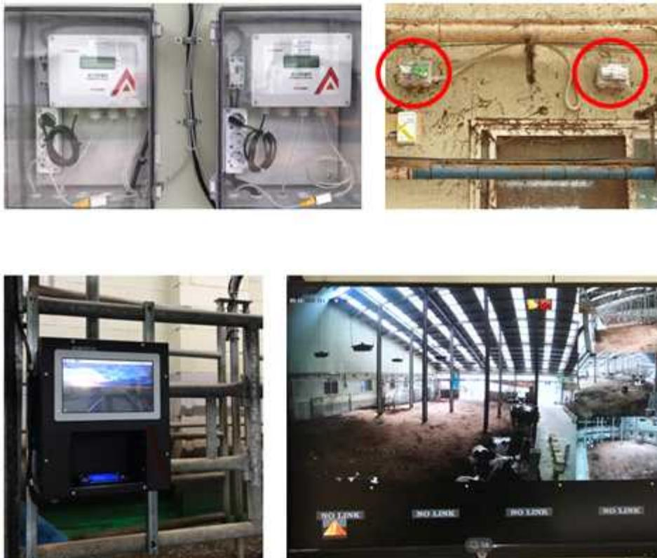
[그림2-42] K목장 유방염 모니터링 장비 및 환경모니터링 장비 설치
