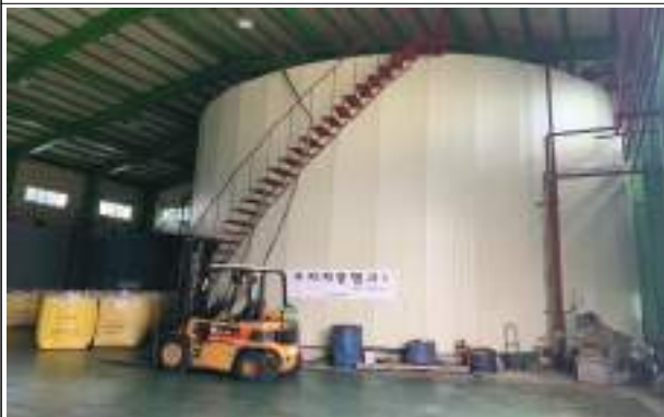
유지저장탱크 및 수지박 보관
