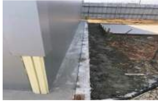
실외기 배치 장소 콘크리트 타설
