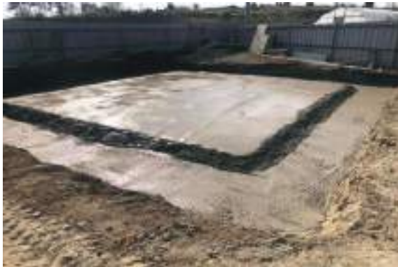
버림 콘크리트 타설
