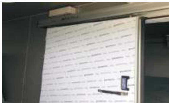
슬라이딩 도어 설치
