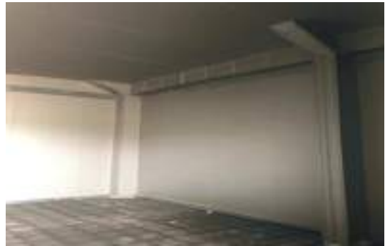
바닥 타설 준비 철근 조립
