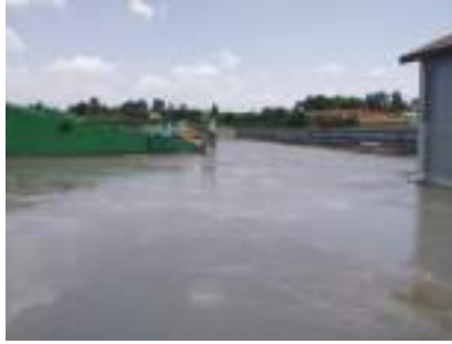
<부지 정리> (기존) 자갈바닥 → (변경) 콘크리트바닥
