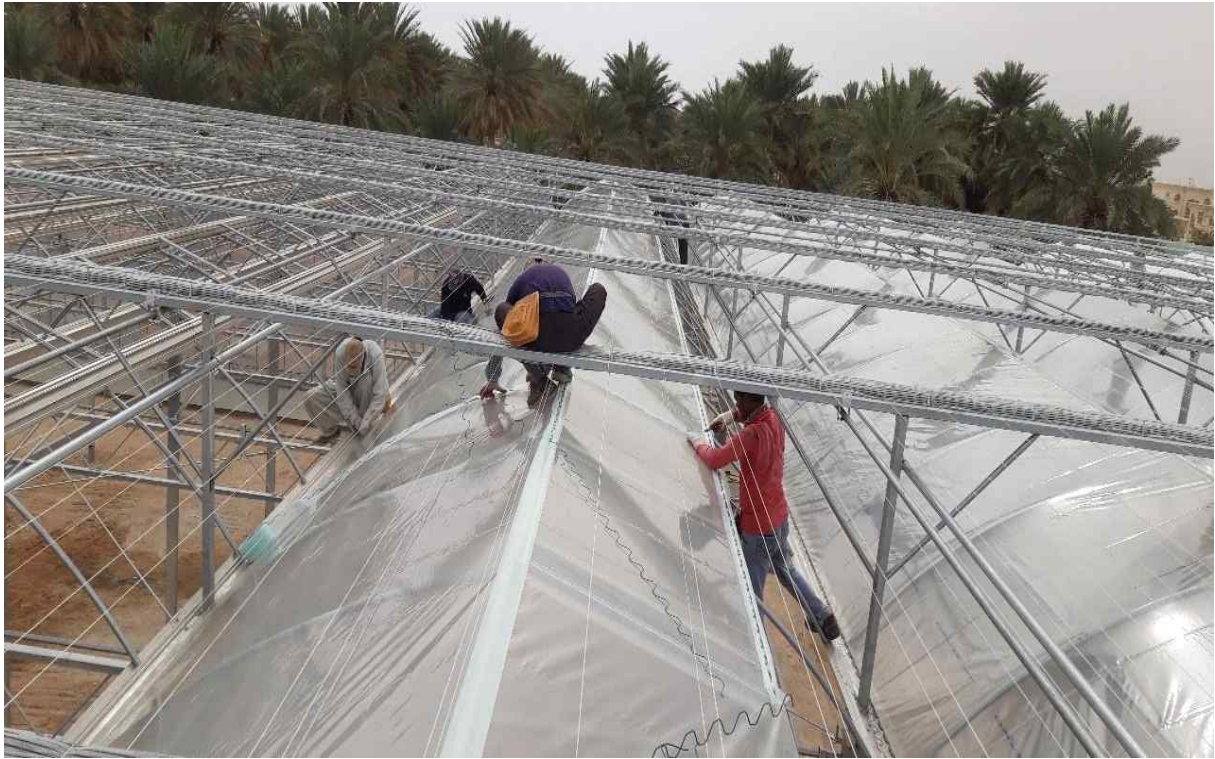
그림 120. UAE 스마트온실 피복공사 도면 및 시공
