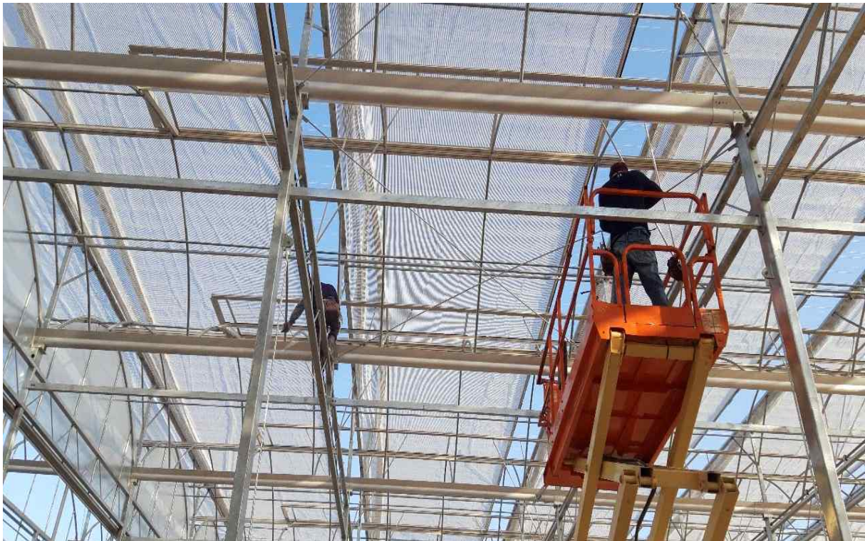
그림 122. UAE 스마트온실 외부차광시스템 도면 및 시공
