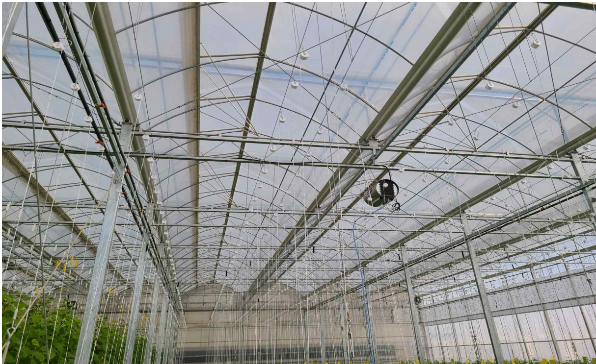
그림 125. UAE 스마트온실 에어 제습팬 및 포그시스템 공사 도면 및 시공
