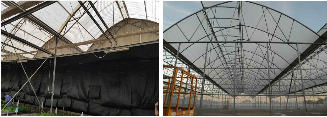
그림 198. 사막 온실 구조 개선안 예시 (좌: 사막형 구형 온실구조, 우 : 한국형 사막온실구조)
