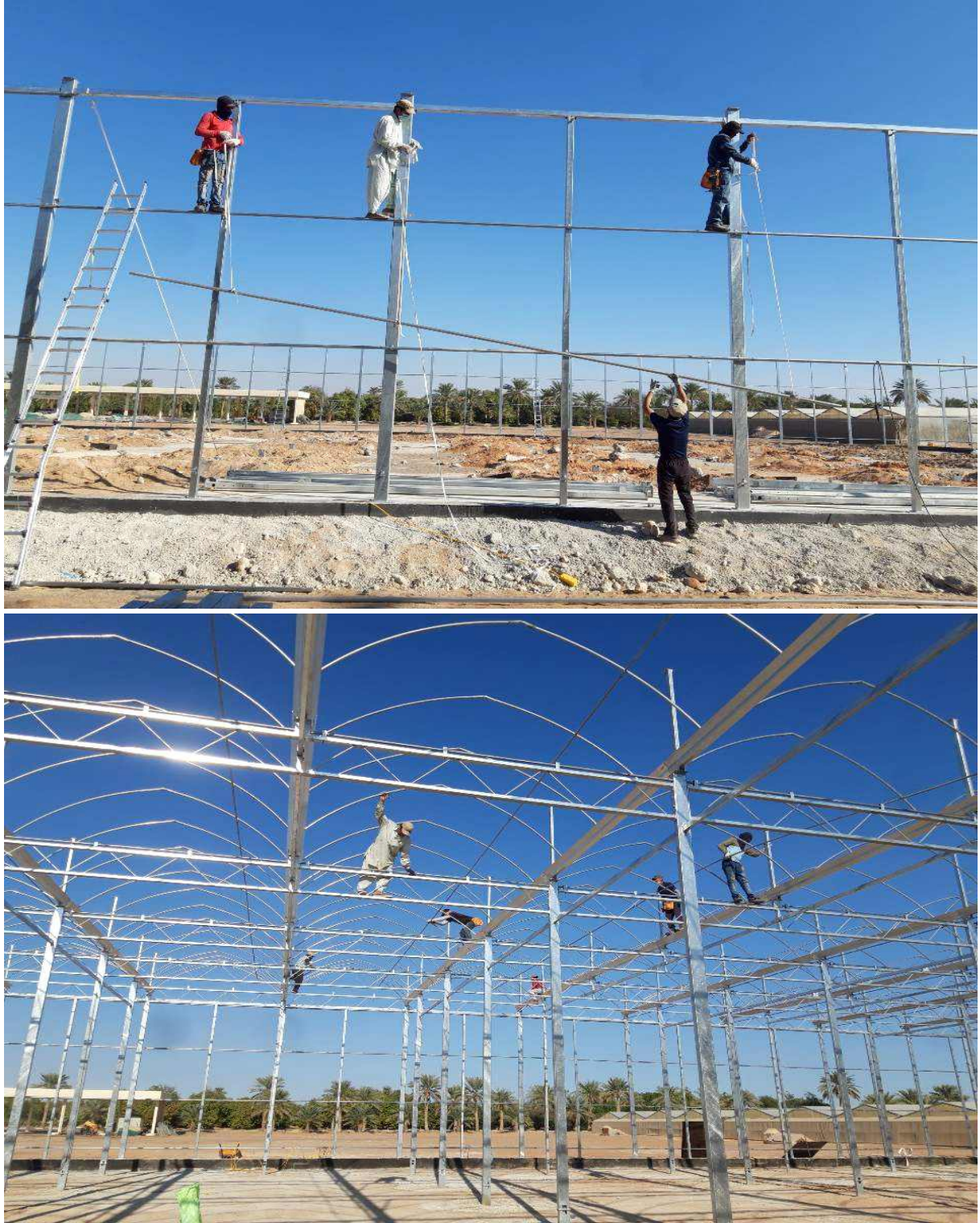
그림 119. UAE 스마트온실 철골공사 도면 및 시공
