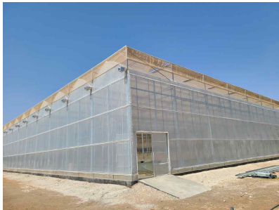
피복 공사/천창개폐/스크린 공사
