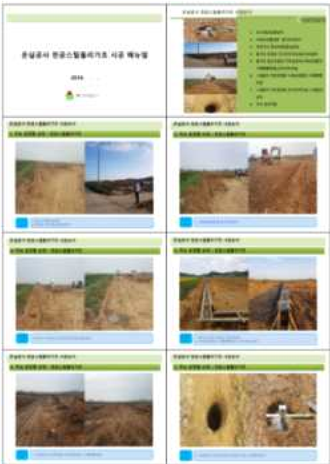
그림 6. 테스트온실 기초 시공 메뉴얼 제작
