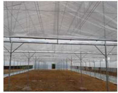
【 광폭형 하우스 내부 전경 】
