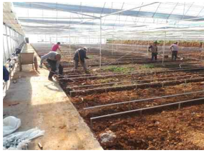
【하우스 내 베드 설치】
