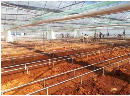
【연동하우스 기초 공사】
