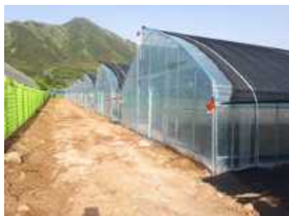
【강원도원 증식하우스 설치】
