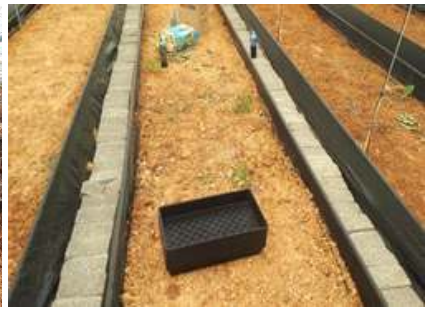
【베드 바닥 배수로 설치】
