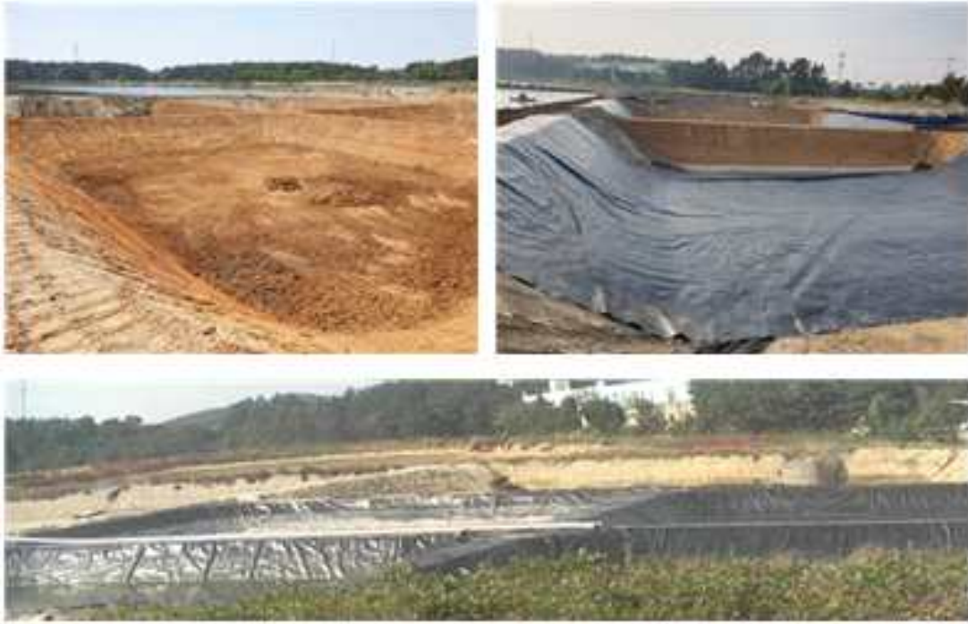
그림 2-1-73. 대왕바리 친어 수용을 위한 노지 구획 및 HDPE sheet 포장.
