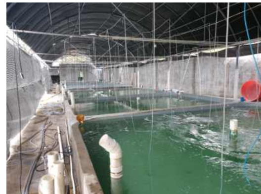
그림 2-1-190. 노지 종자생산을 위한 작업 및 노지 수확 후 중간 육성을 위한 콘크리트 수조.
