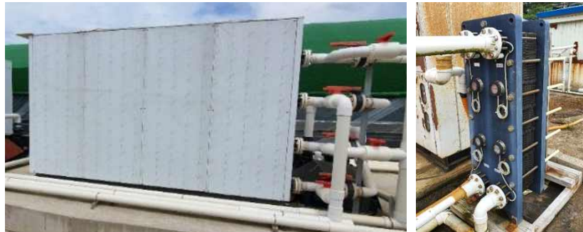
그림 2-1-109. 조기 산란 유도용 수온 조절을 위한 히트펌프(좌) 및 열교환기(우).
