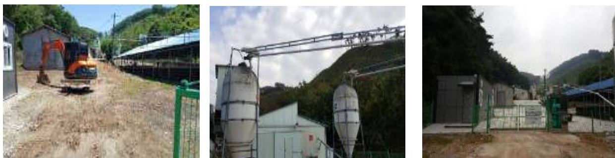
〈 농장 내 콘크리트 타설 〉 〈 외부 사료이송장치 설치 〉 〈 보강된 농장 진입 환경 〉
