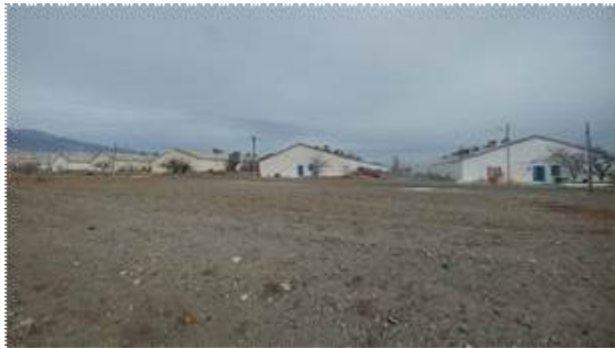
Altyn took factory 전경 (2번째 라인 계사, 초생추 사육)
