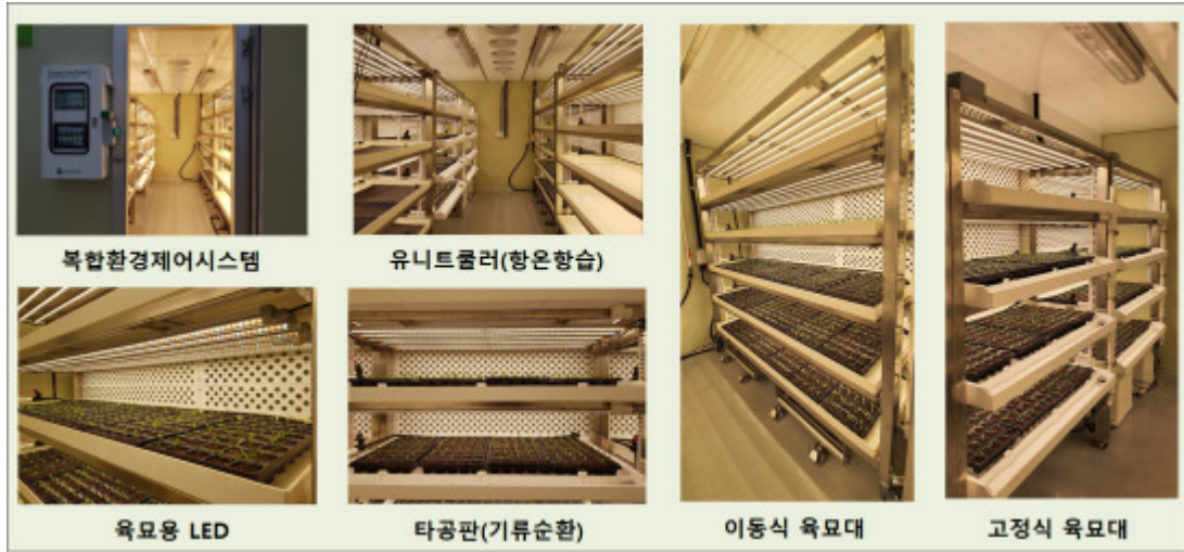
그림7. 식물공장형육묘시스템 구성
