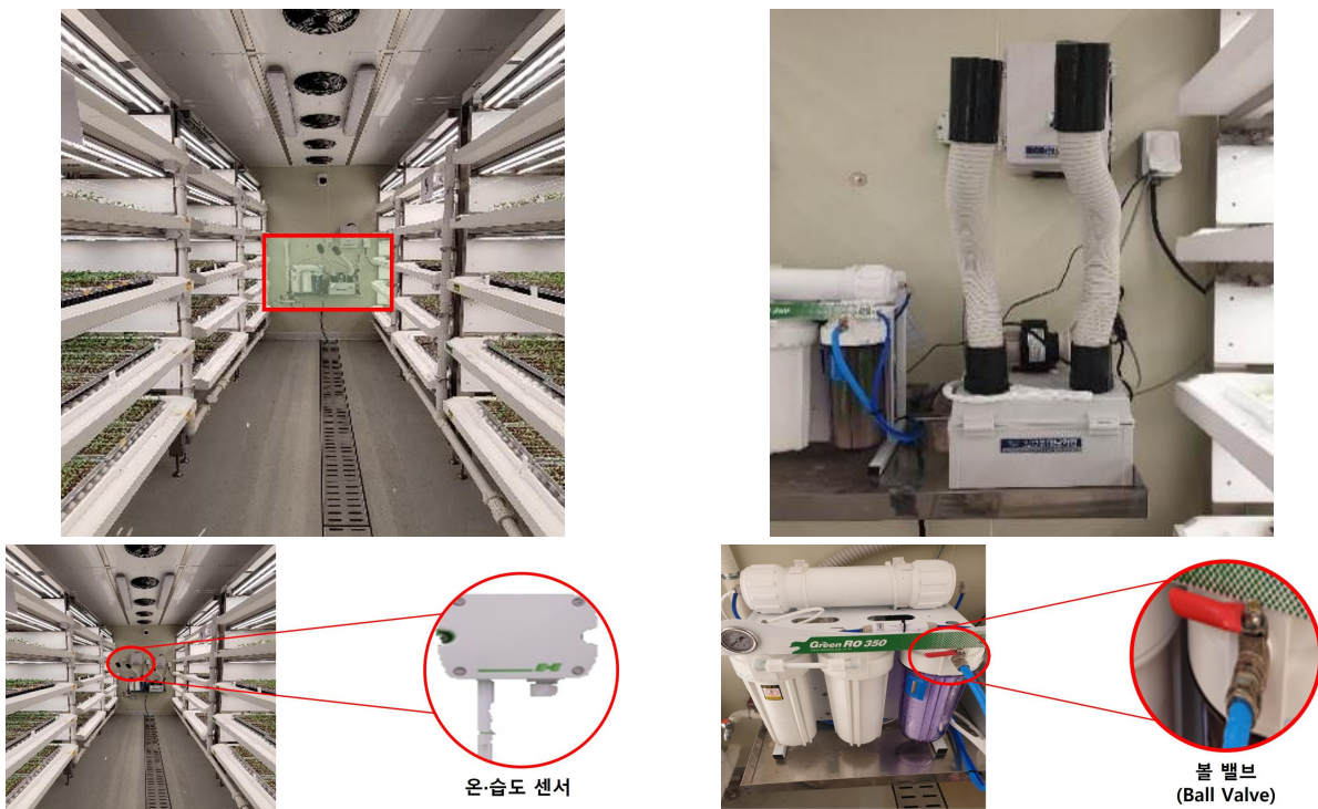
그림57. 식물공장형육묘시스템 내부 가습기, 가습기 필터 및 온·습도 센서
