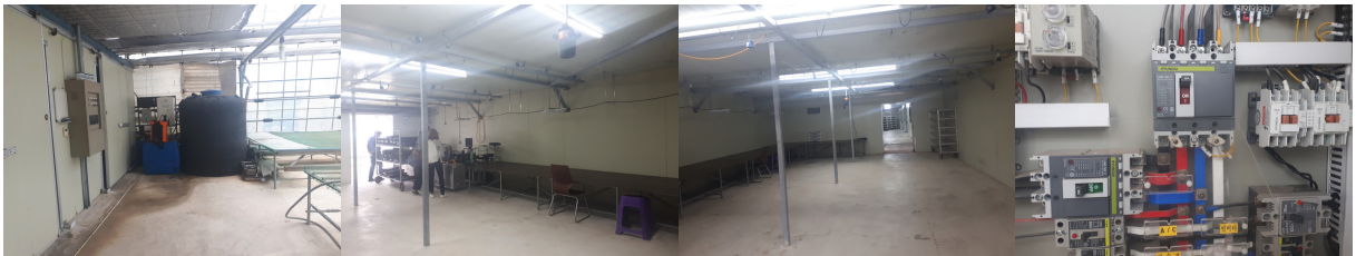
그림10. 내*산 육묘장 설치 공간 확인 및 전력상태 확인
