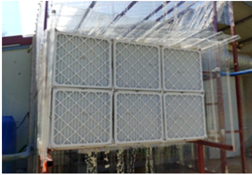
투명PC재질의 에어컨밀폐실 에어필터 및 환설치 모습
