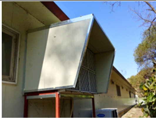
투명PC재질의 에어컨밀폐실 에어필터 및 환설치 모습
