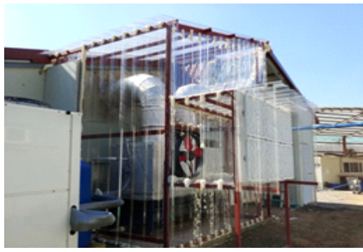
투명PC재질의 에어컨밀폐실 에어필터 및 환설치 모습
