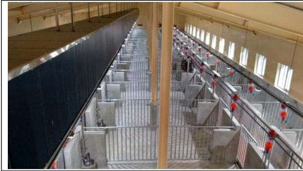
중간 덕트 시공
