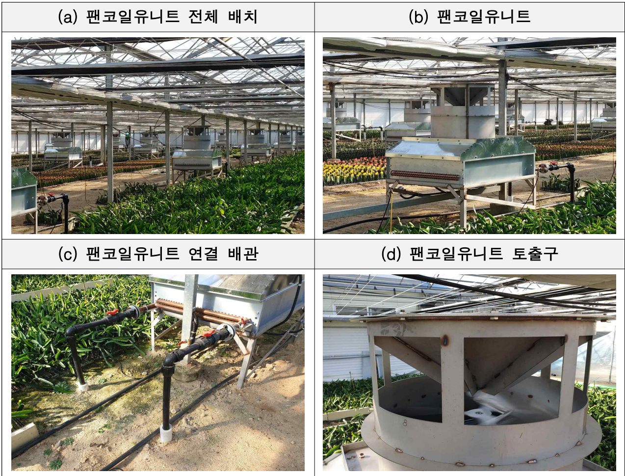
[그림 65] 팬코일유니트 설치 사진
