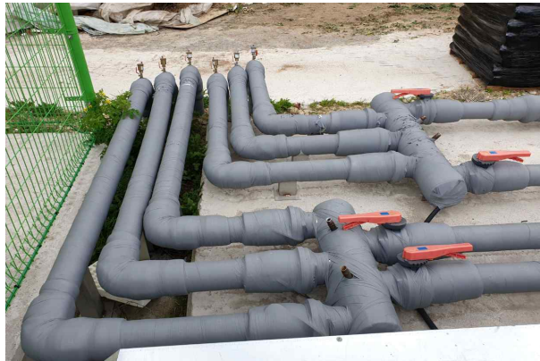
[그림 62] 공기열 히트펌프 설치 사진
