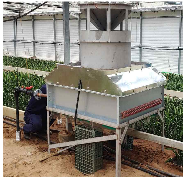
[그림 30] 상부토출형 팬코일유닛 제작 및 설치 사진
