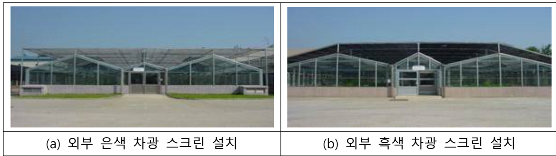
[그림 3] 외부 차광 스크린 설치
