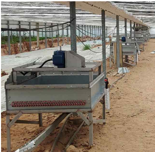
[그림 30] 상부토출형 팬코일유닛 제작 및 설치 사진
