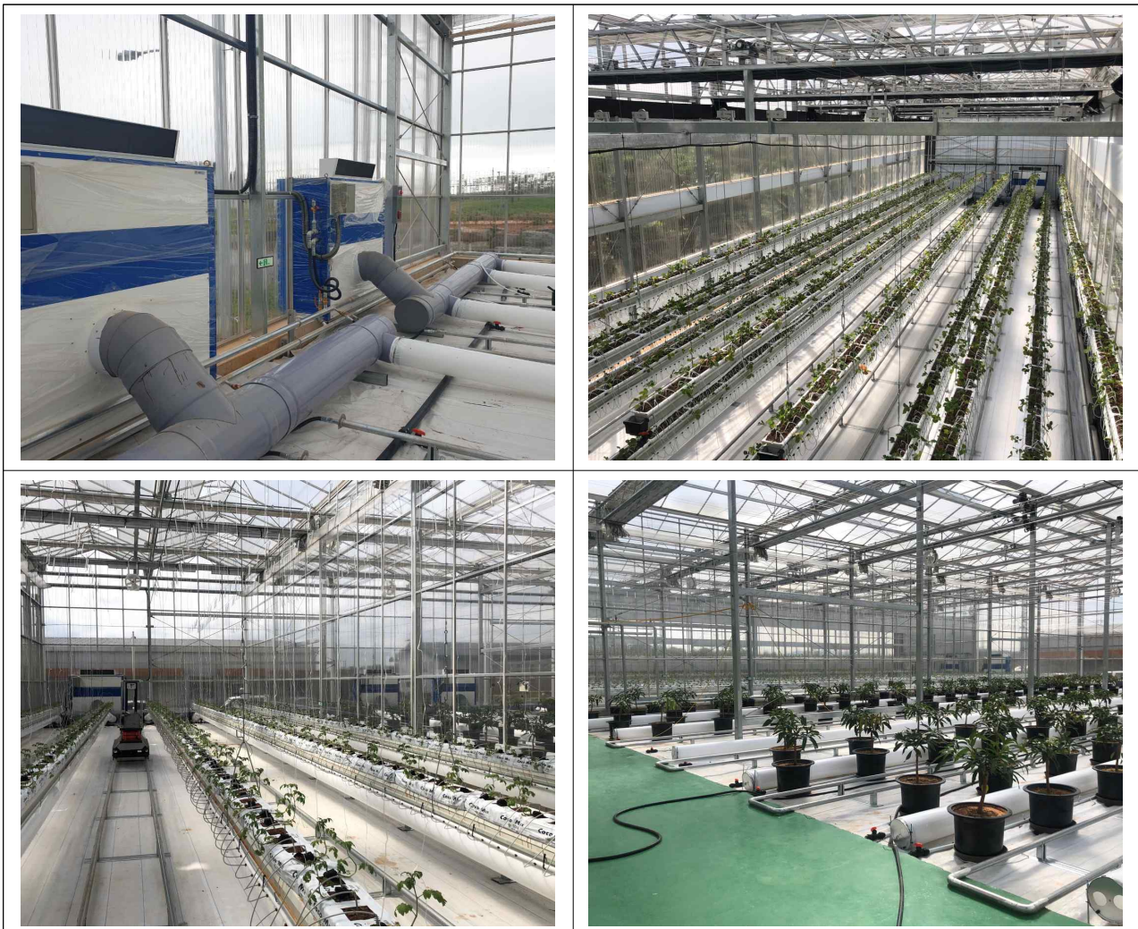
[그림 130] 추가 실증 온실 비닐덕트 설치 사진
