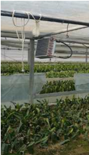
(a) 팬코일유니트 설치
