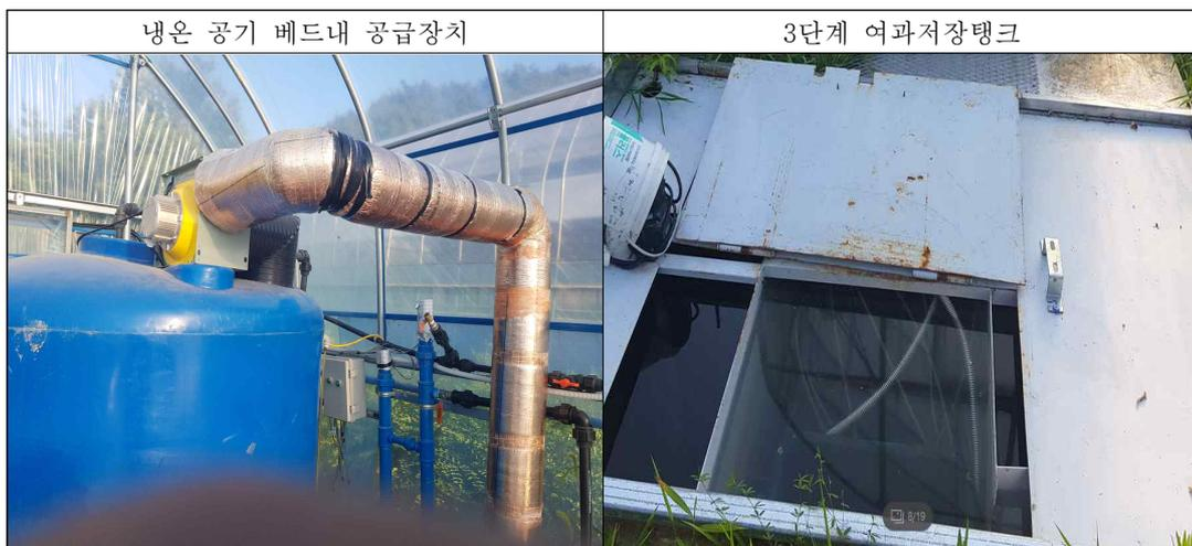
[그림 2-13] 대기 공급 장치 및 여과저장탱크 설치 모습
