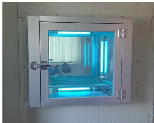
[그림 52] 반입 물품 소독을 위한 자외선 소독기 설치
