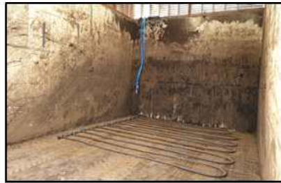
그림 96. 저압 분산 고무 질호스(유니바이오토크스) 설치 모식도 및 설치방법
