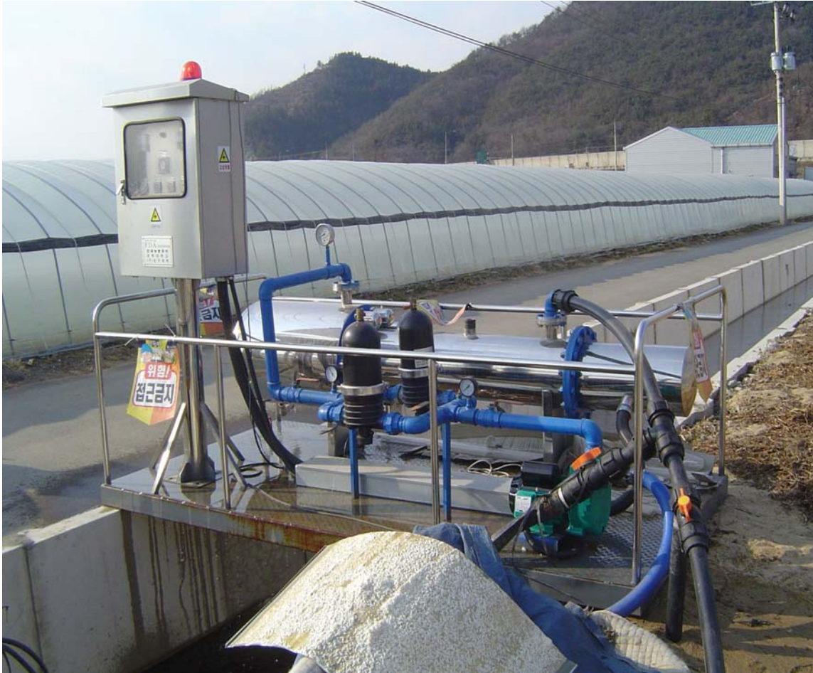
<그림 3-37> 시작품 설치 전경
