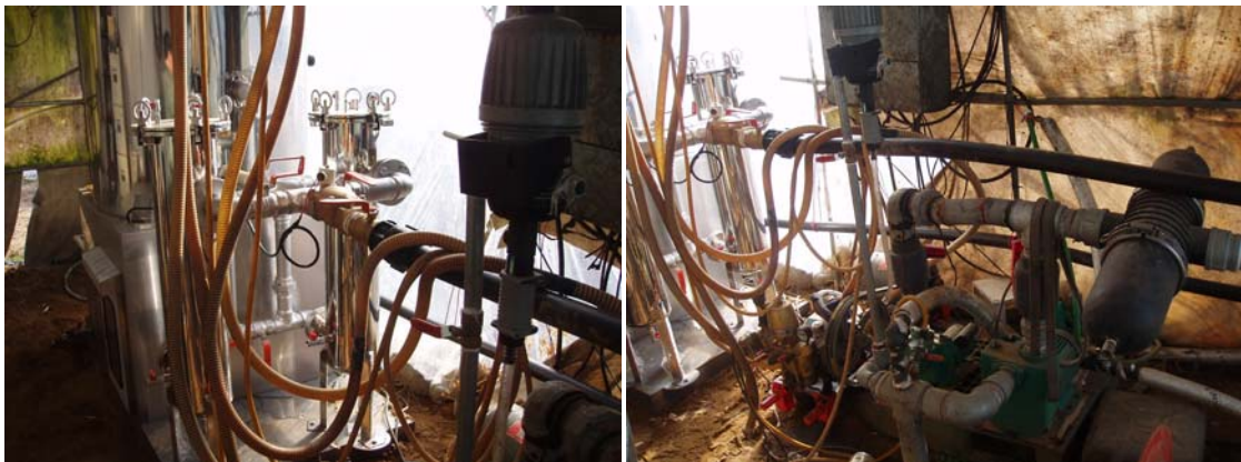
<그림 3-88> FDA 시스템과 기존의 모래여과기의 연결된 상태
