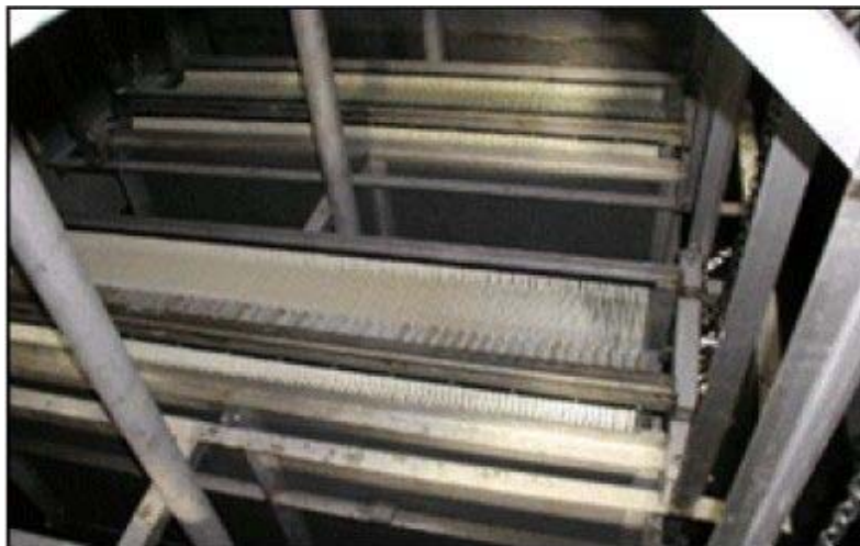
<그림 2-24> SMBR (Submerged Membrane Bioreactor) 공법
