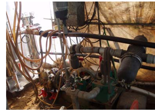
<그림 3-21> FDA 시스템과 기존의 모래여과기의 연결된 상태
