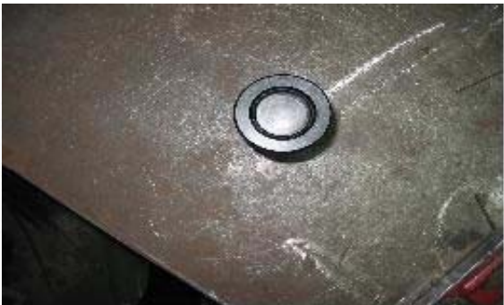
<그림3-10> 자외선 모듈 물탱크 투시장
