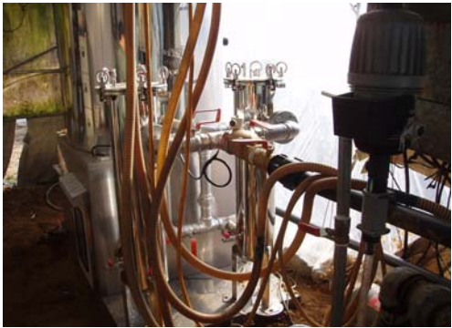
<그림 3-21> FDA 시스템과 기존의 모래여과기의 연결된 상태
