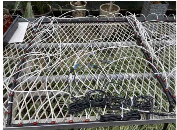
그림 48. 자동관수 시스템 설치
