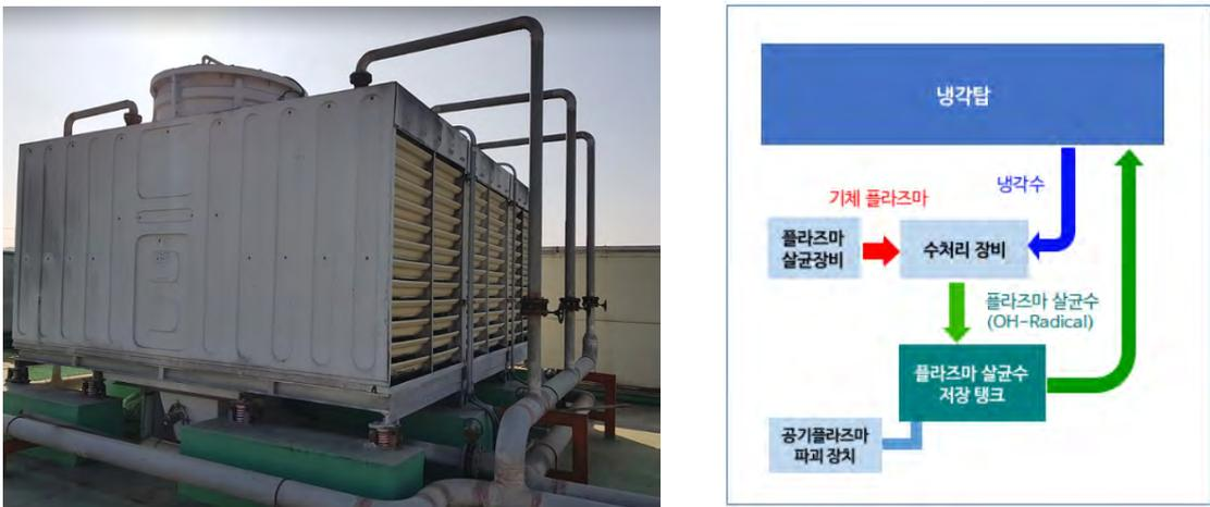
(그림 77) 플라즈마 살균수를 이용한 냉각탑 살균 시스템
