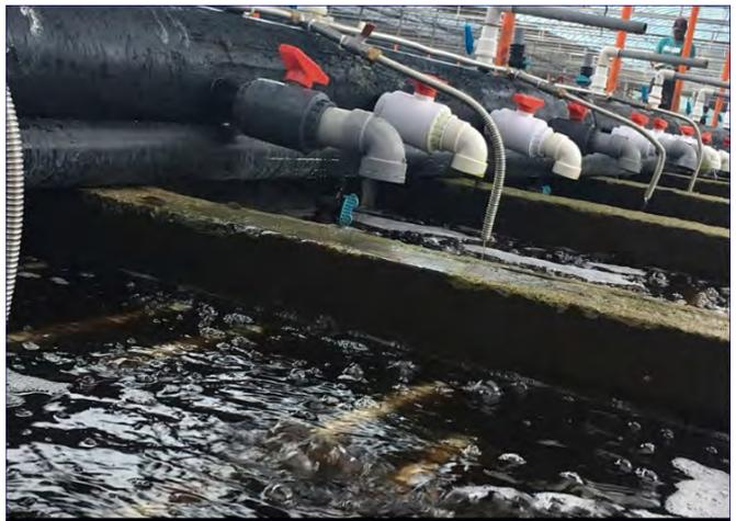
(그림 82) 플라즈마 살균수를 이용한 지하수 살균 처리
