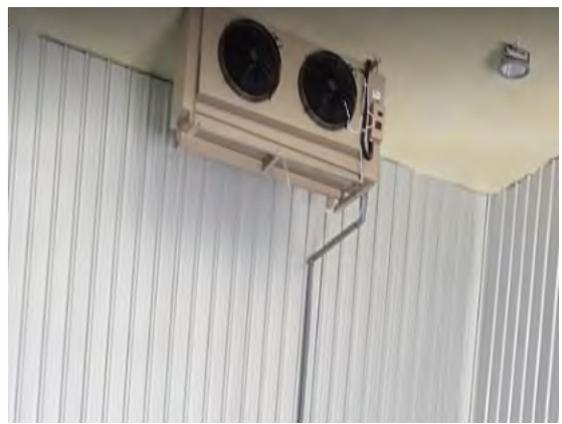
(그림 83) 저온저장창고 신선도 유지기 설치 (양파등 엽근채류)
