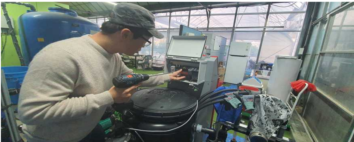
그림 67) 농촌진흥청 스마트 온실 테스트베드 설치 중
