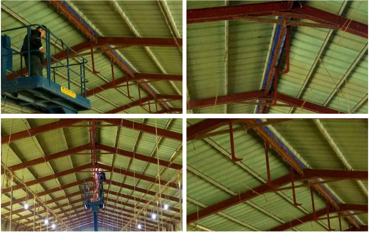
그림 135 실증농가 1호 김제 농가 레일 구조물 시공
