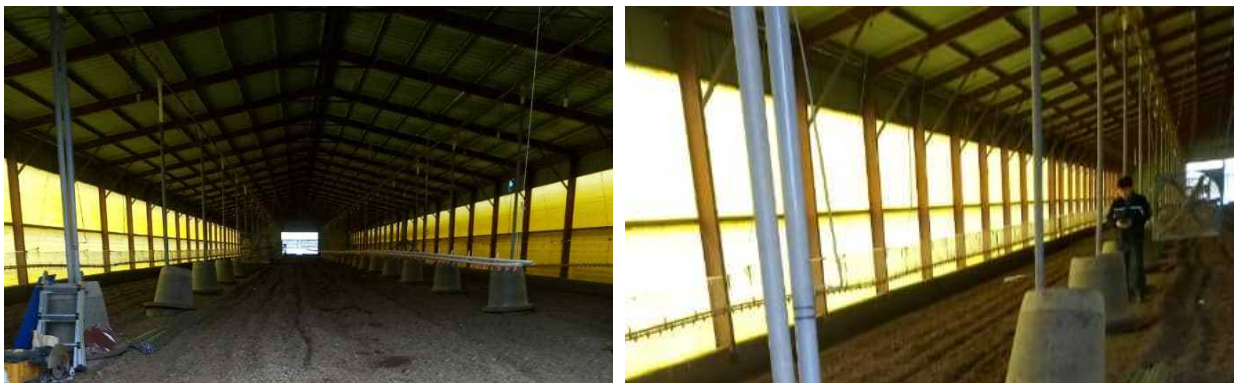
그림 134 실증농가 1호 김제 농가 시공 현장
