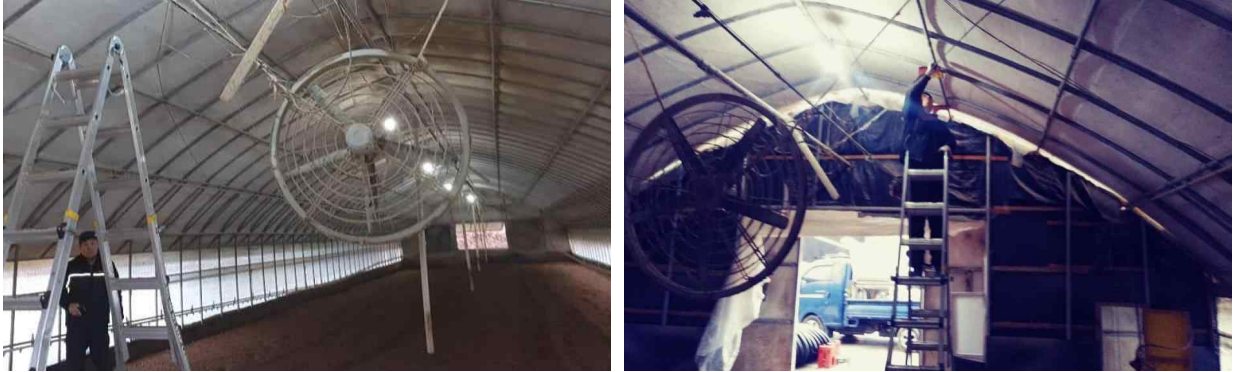
그림 146 실증농가 3호(하우스형) 영암 농가 시공 현장
