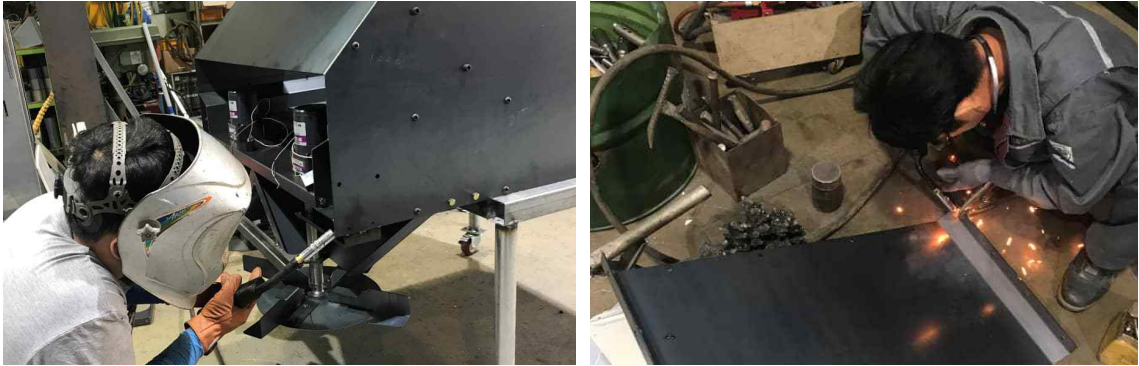
그림 21 바닥 깔짚 살포장치 제조 현장(주식회사 다운 공장)
