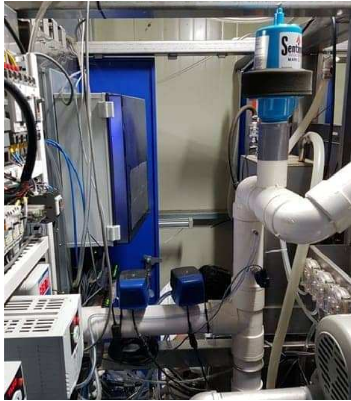
그림 129 진공 컨트롤러 및 압력 센서의 설치 상태
