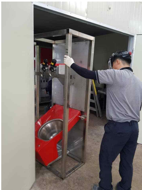
그림 188 착유실 내 급이기 설치 중
