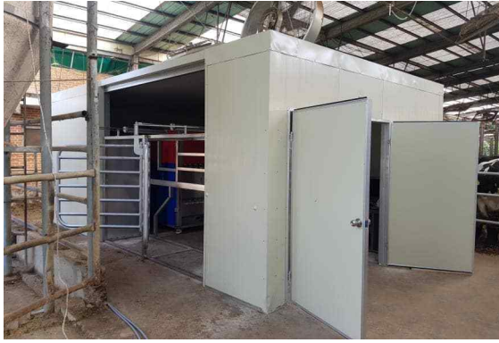
그림 186 착유실 외벽 설치
