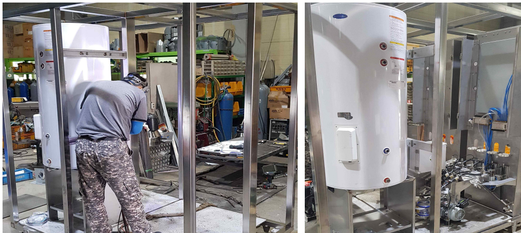
그림 181 세척용 온수 탱크 조립 및 연결
