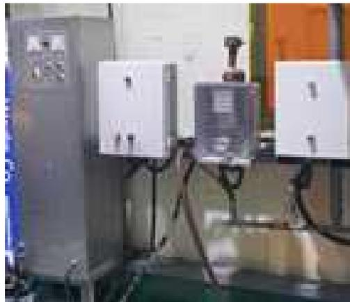
그림 3 유전체장벽방전(DBD) 플라즈마 발생장치 설치 사진
