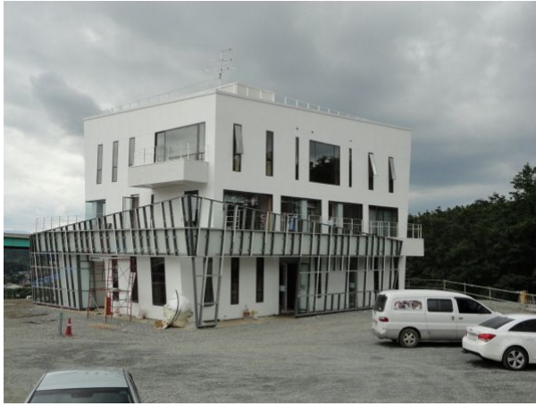
삽살개 육종연구소 공사현장(1차 공사 70%)
