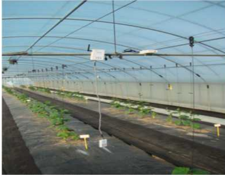
<시설하우스 내 센서노드 설치형태>
