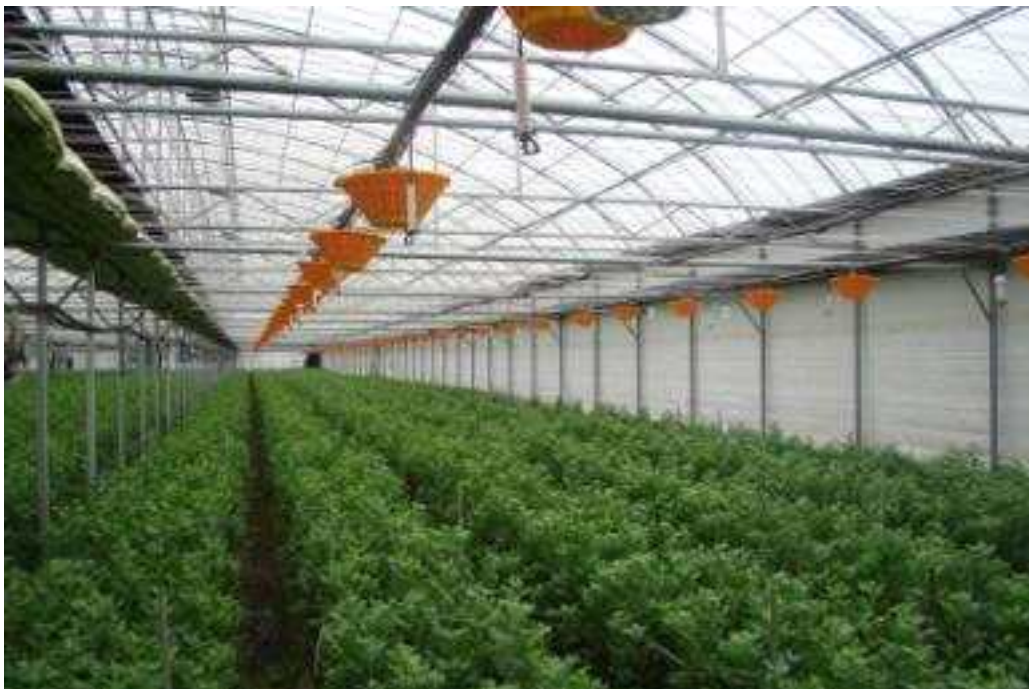
<LED 광처리 장치 제품 설치 활용 사진>
