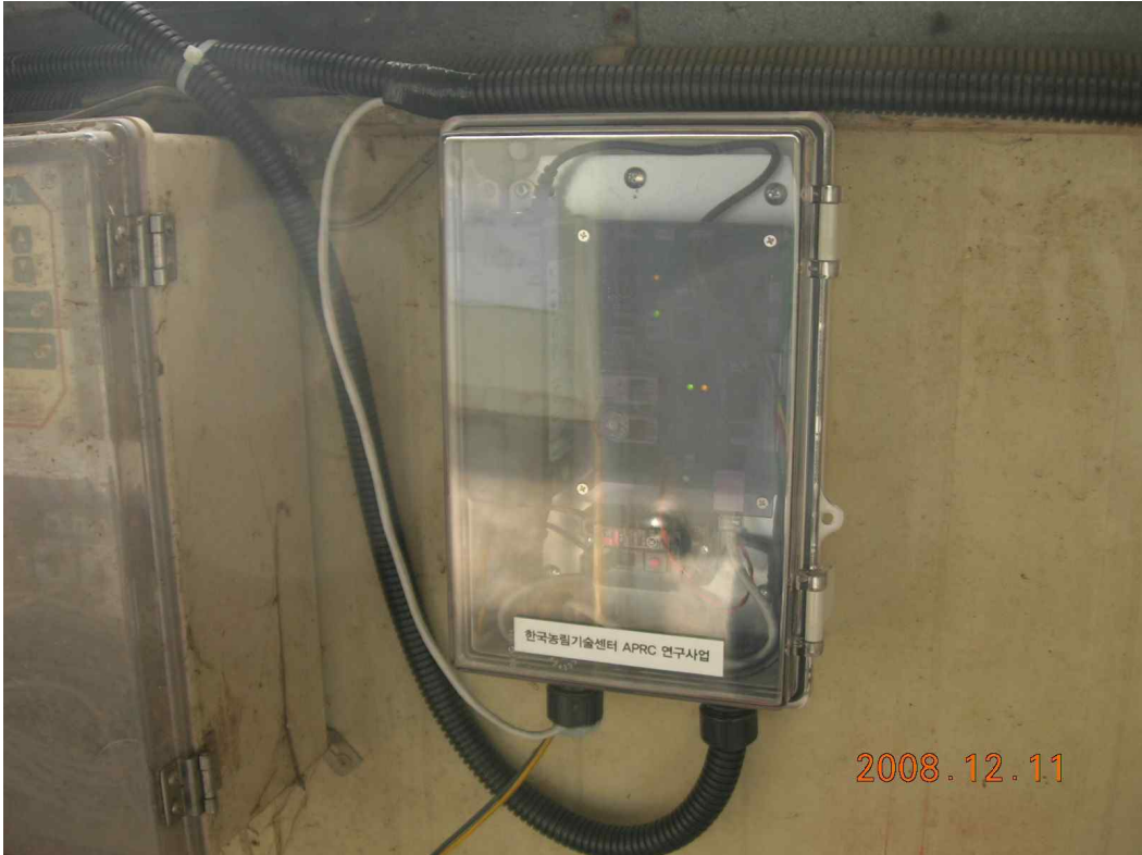
그림 3.81 실험 돈사시설에 대한 센서 컨트롤러 설치현황
