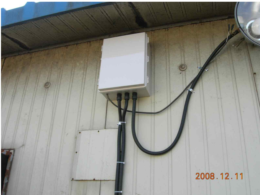
그림 3.80 실험 돈사시설에 대한 통신네트워크 설치현황
