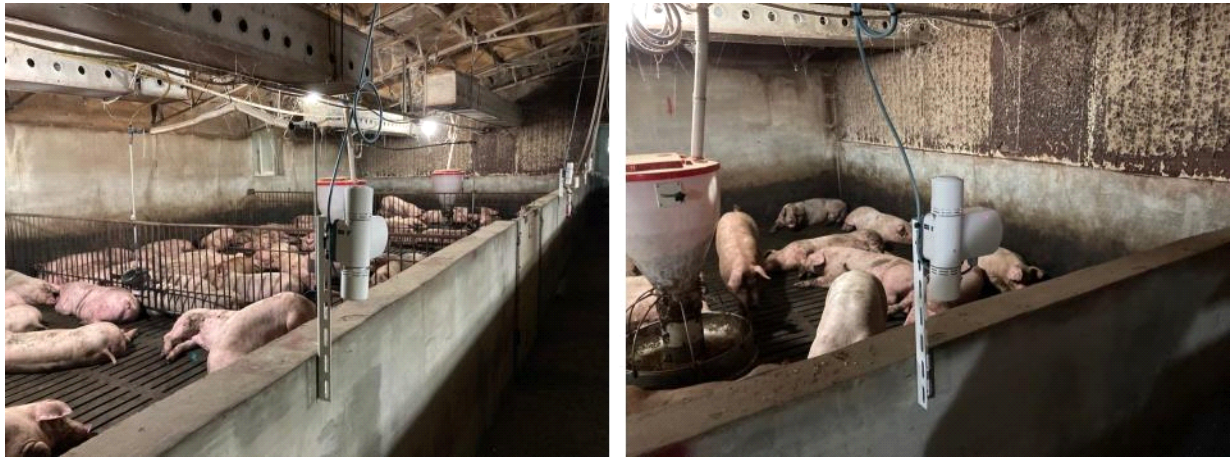
그림 113. 실증 축산 농가 내 환경 센서 설치 (B)
