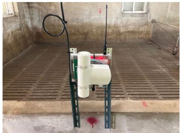
그림 112. 실증 축산 농가 내 환경 센서 설치 (A)
