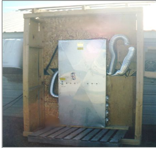
<그림 3> 돈사 시설에 적용된 악취 제어용 오존 발생기 실물도
