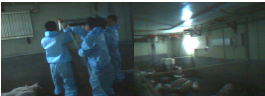
<그림 15> 실험돈사 내부 측벽에 설치된 공기정화기의 모습
