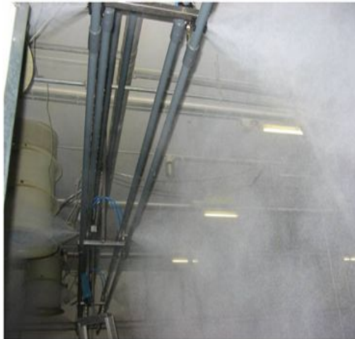
<그림 4> 돈사 시설에 적용된 악취 제어용 분무 시스템 실물도
