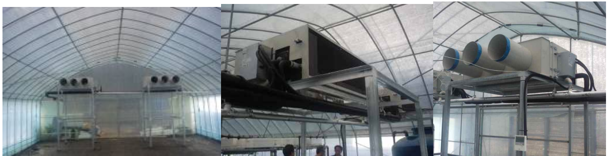
사진 14. 설치된 고정압 덕트 (스파이럴 덕트 적용 전)
