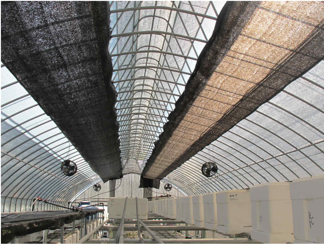
사진 24. 하우스 시설 내 fan 및 차광망 설치
