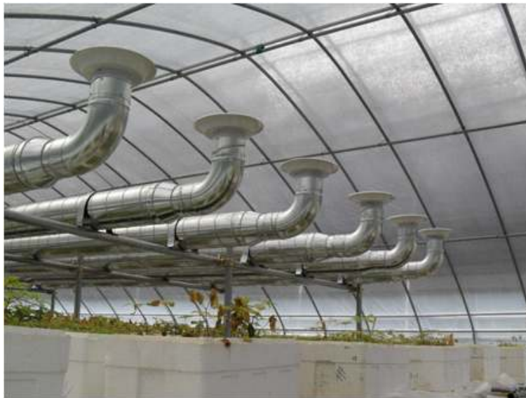
사진 18. 고른 기류 공급을 위한 디퓨저 설치 후
