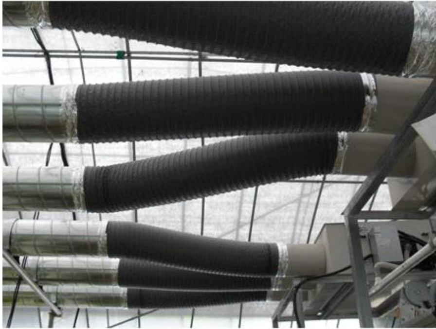
사진 17. 매립덕트 스파이럴 덕트 연결 전&후
