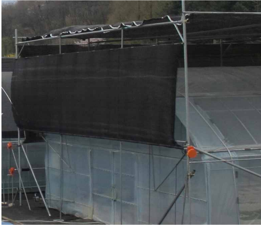
사진 25. 기본형 하우스 차광시설 변경 전
