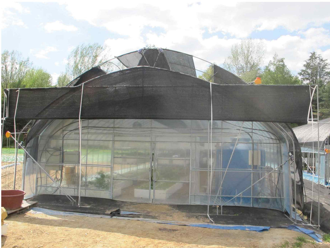
사진 23. 사진 앞쪽 차광망 설치
