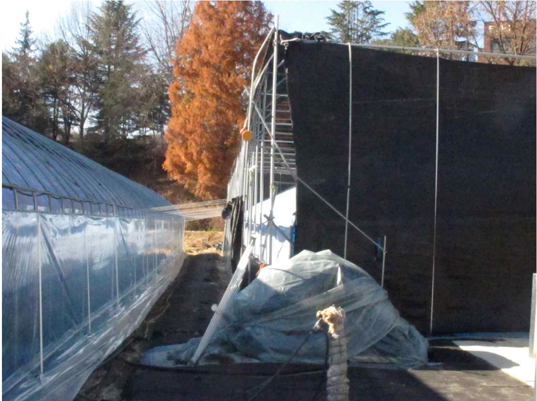
사진 33. 하우스 측면 광 차단을 위해 하우스 간 차광시설 설치
