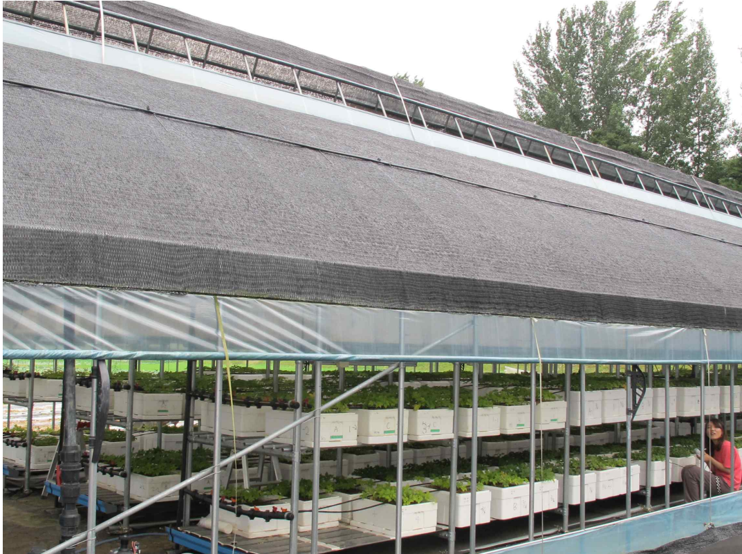
사진 20. 하우스 외부에 포그 설치
