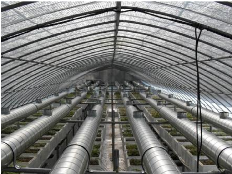
사진 16. 스파이럴 덕트 작업 후
