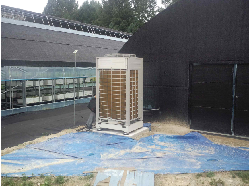
사진 13. 설치된 Multi V Super III LRD-2908DH
