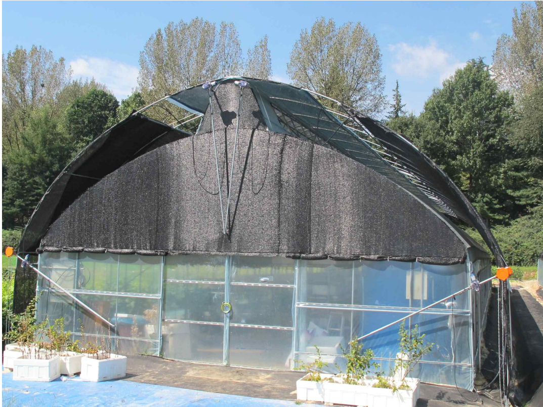
사진 22. 몽골형 하우스 외부 프레임 추가 모델 (변경 후)
