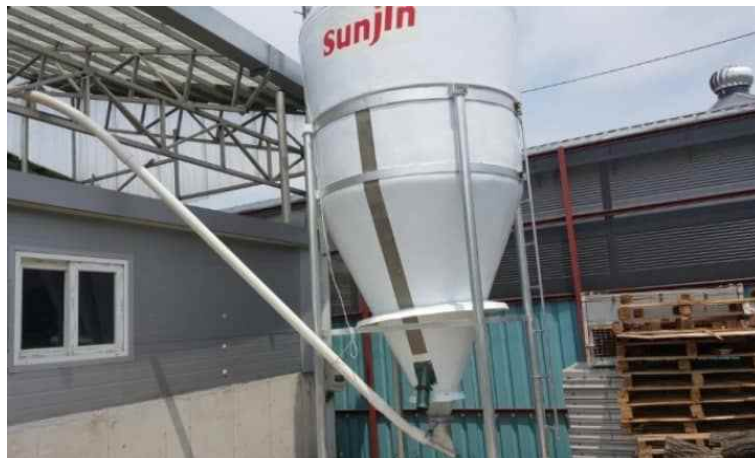
그림 139. 사료빈 반구동부 설치[예시]
