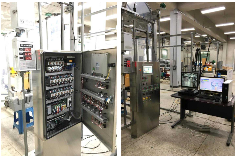
그림 12. 실증 온실 제어장치와 관리 시스템의 구성
