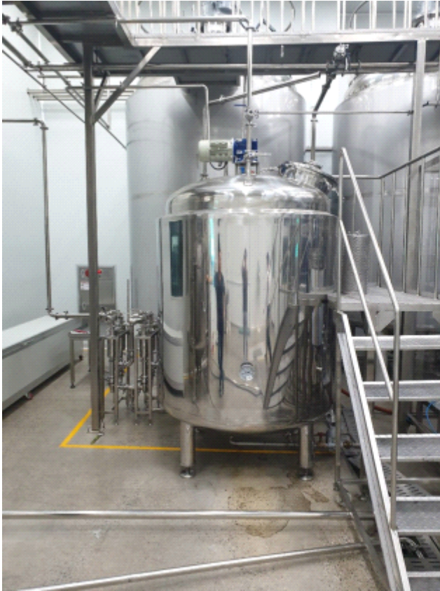
그림 66 1차 저장·농축 탱크 (2루베) 및 하우징 필터
