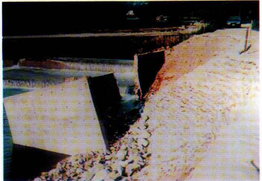
집중호우 및 태풍 '올가'의 영향으로 강원도 양구군 남면 용하리의 보 날개벽 유실 및 하천제방 응급복구 완료 광경 ('99. 8)
