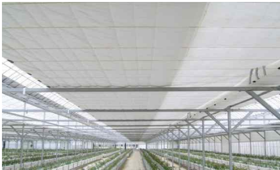
Fig. 다겹보온커튼이 설치된 온실 내부
