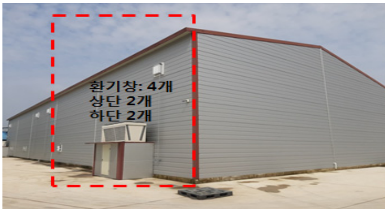
그림 4-12. 적정시설 기준 개선(창고 내부 안전시설)
