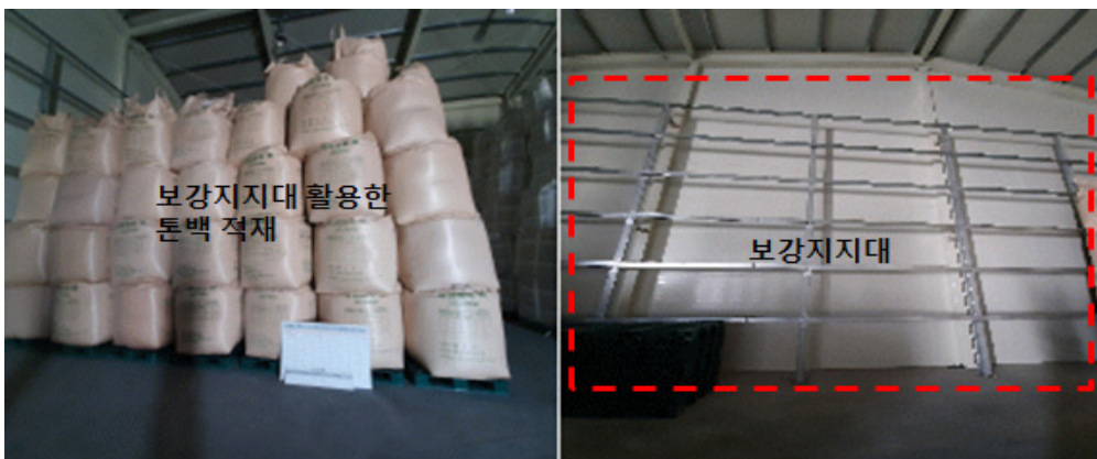
그림 4-11. 적정시설 기준 개선(창고 내부 안전시설)
