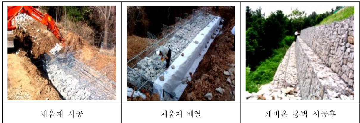
그림 1-6. 케비온 옹벽 시공과정
