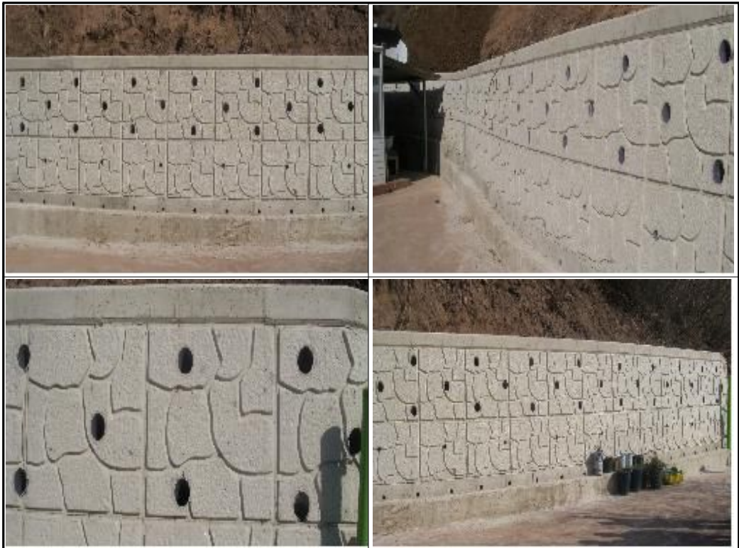
사진 1-1. 시공된 생태옹벽 식생홀 전경
