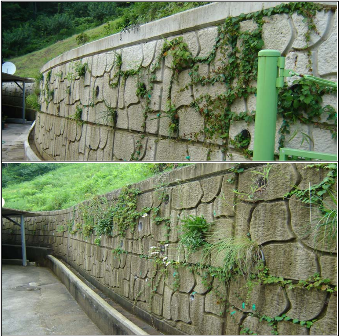
사진 1-12. 맞춤형 생태옹벽 전체 모습
