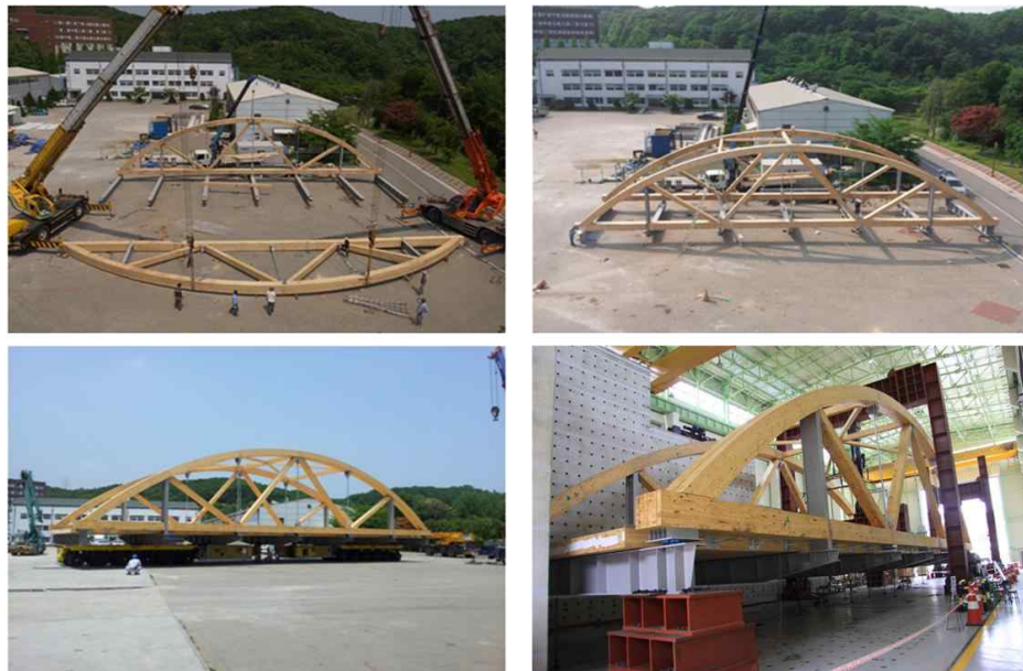
<목조교량 현장 조립 및 설치 모습>
