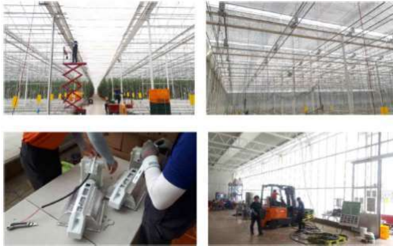
그림 51. top-light 배선 및 설치 진행
