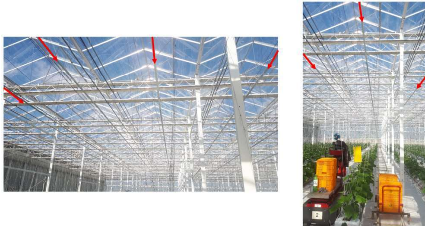
그림 49. Top-light 배치용 C형강 설치
