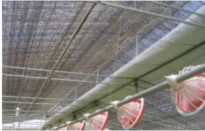
그림 2-10. 복층온실계사의 차광시스템
